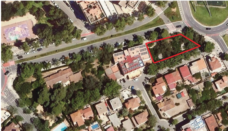
Foto aèria de la finca on es troba ubicada la Residència Ítaca Fortuny de Reus i en vermell el perímetre de la zona del jardí.
