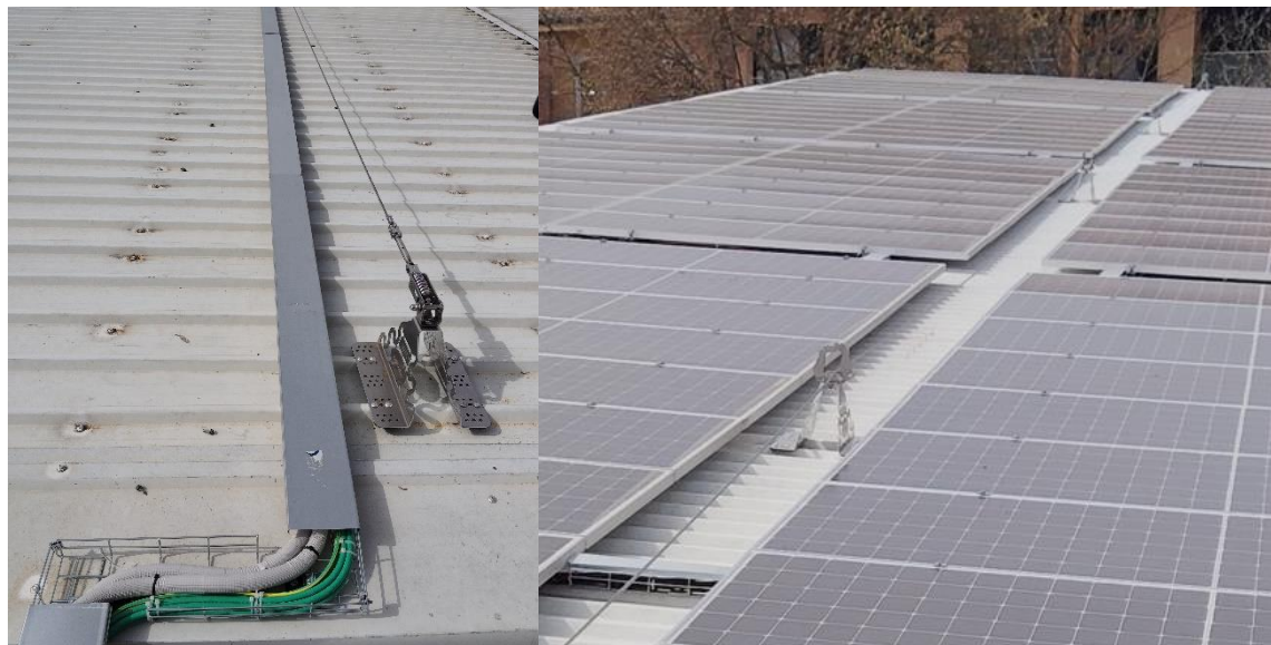
Figura 6 Exemple elements línia de vida: element als extrems i cable d'acer(esq.) i suports intermedis(drta.)
