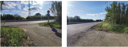
Figura 4.12. Camí de Bellissens quan arriba a la carretera T-315
