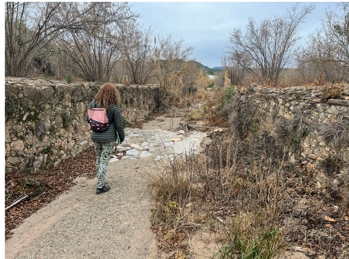
Foto. La capçalera del barranc del Molí es converteix en un caixó entre murs de parcel·les agrícoles d'avellaners. Font: ©Eduardo Soler
