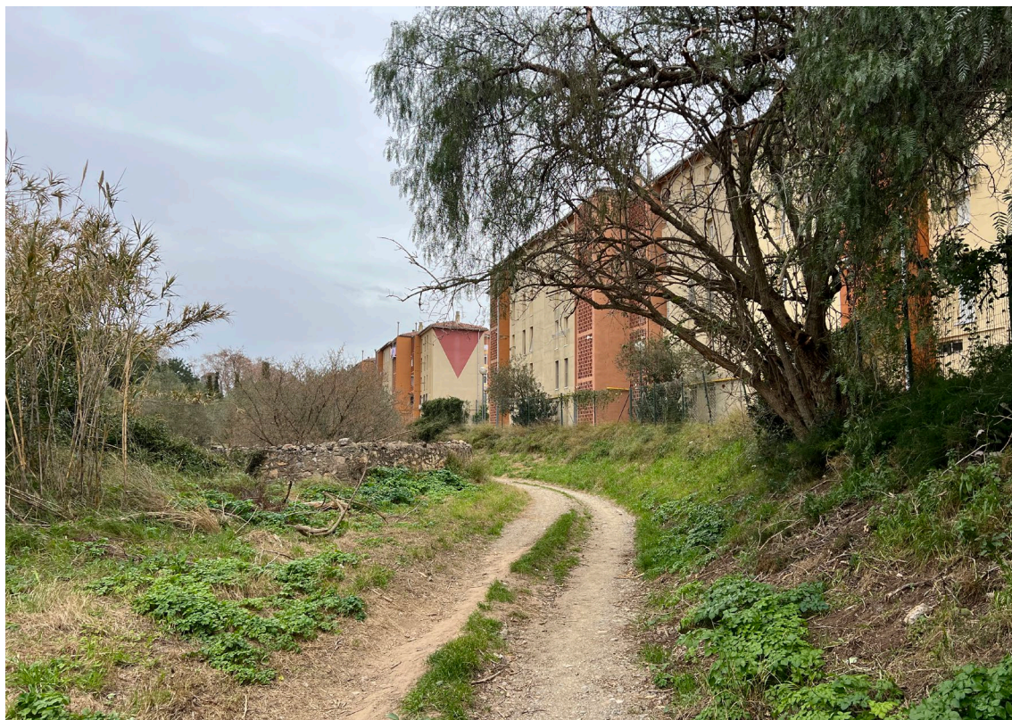
Foto. Tram obert a la zona central dels edificis, on destaquen peus de fals pebrer. Font: ©Eduardo Soler
