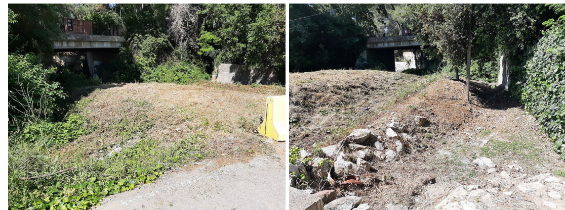
Fotos. Rases de drenatge actuals que no seran modificades amb la construcció del jardí de pluja. Font: ©Eduardo Soler
