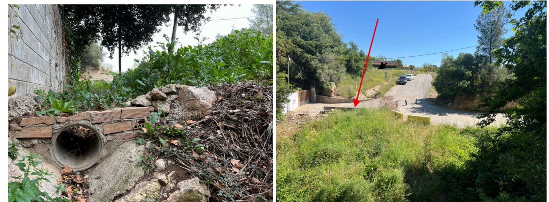
Fotos. Estructures obsoletes que es poden demolir. Font: ©Eduardo Soler
