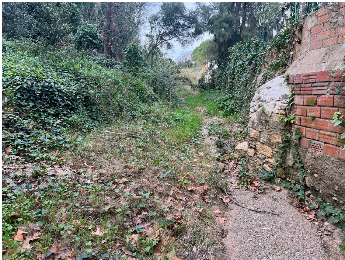
Fotos. Zona on s'acumulen sediments que constreñeix la llera. Font: ©Eduardo Soler
