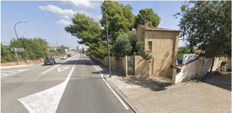
DF1. Carretera C-14z, Av. Montblanc.
