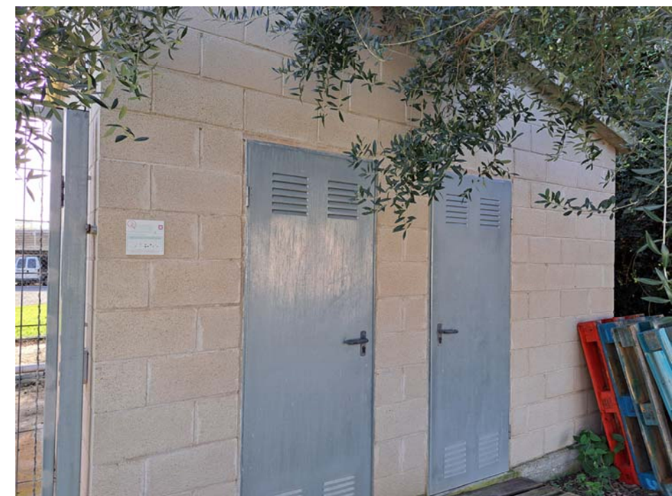
12. Caseta de cloració existent
