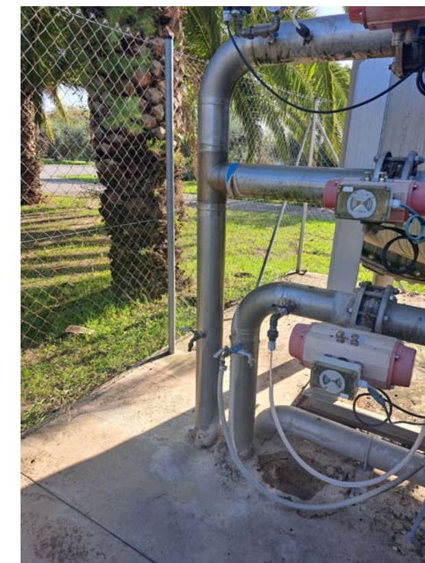
8. Tubs d'entrada, sortida i purga del filtre de carbó
