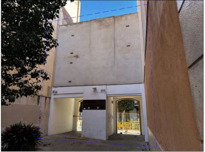
FAÇANA POSTERIOR, PORTAL DEL CARME
