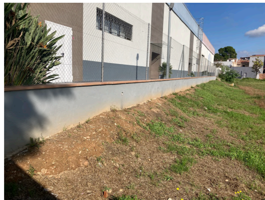
Tancament del perímetre nord del solar.
