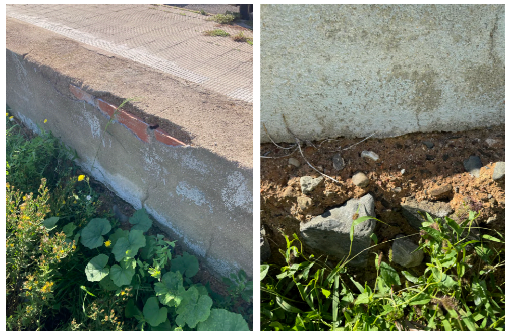
Detall del mur i pilars entre el solar i Carrer Astorga
