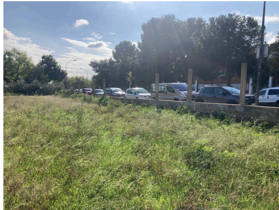
Detalls del mur entre el solar i el carrer Astorga
