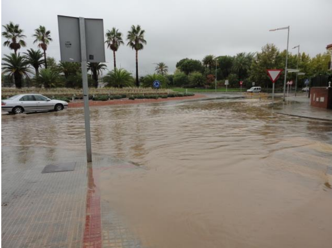
Figura 14. Nivel de la lámina de agua en zona de circulación de vehículos y parte del acerado. Ajuntament de Reus.
