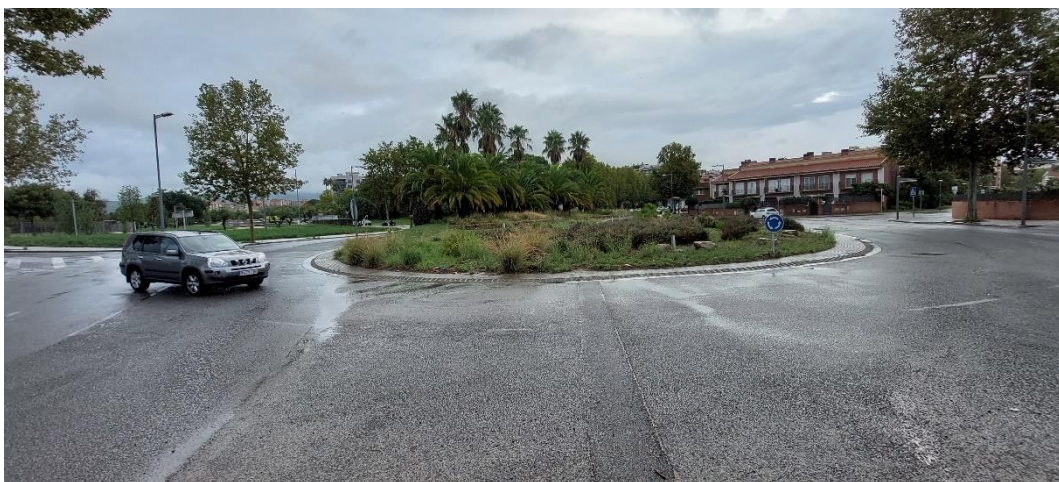
Figura 20. Vista general de la entrada de la zona suroeste de la Avinguda de Riudoms donde se aprecian los regatos que describe la escorrentía al entrar a la rotonda. Ajuntament de Reus.
