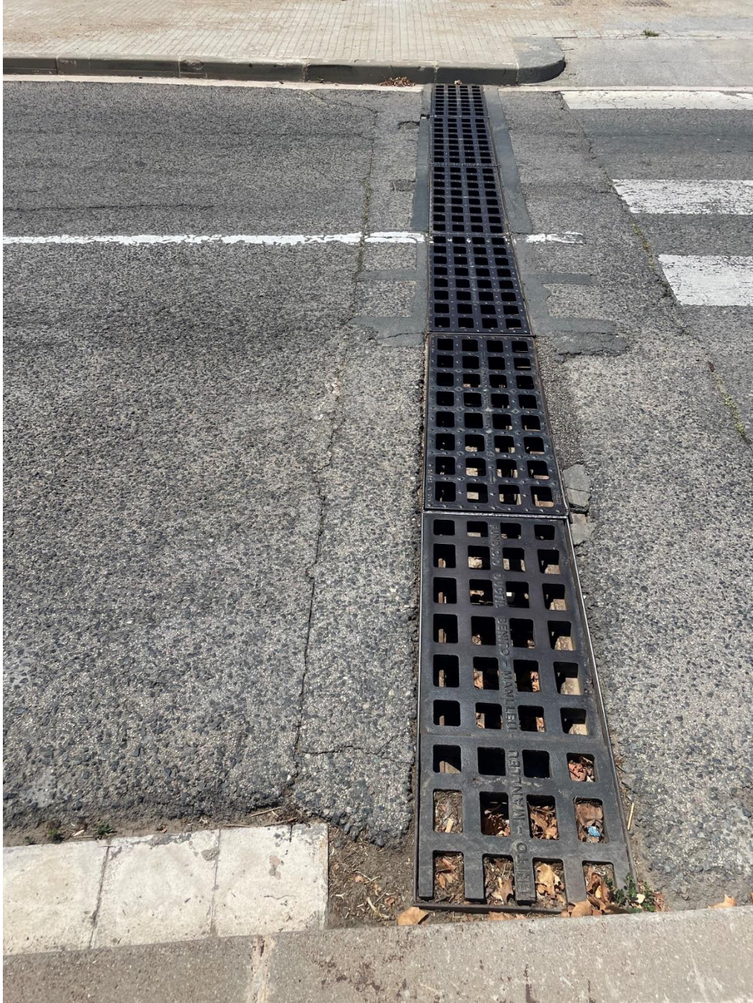
Figura 23. Detalle de reja que recoge la escorrentía del Carrer de la Ginesta aguas arriba e impide que lleguen a la rotonda.
