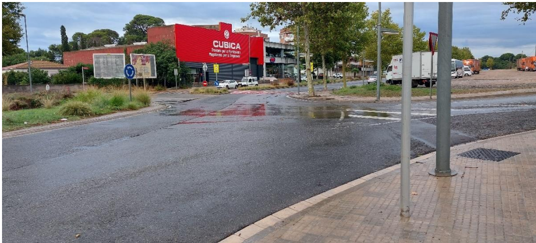
Figura 19. Entrada a la rotonda desde el Camí del Roquí donde se aprecia la entrada central de escorrentía.
