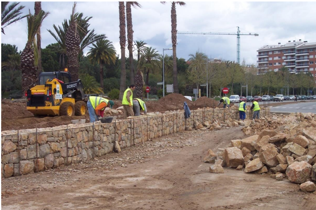
Figura 3. Construcción de muros del proyecto de ajardinamiento. Se considera el color de la piedra para la ejecución del actual proyecto. Ajuntament de Reus.
