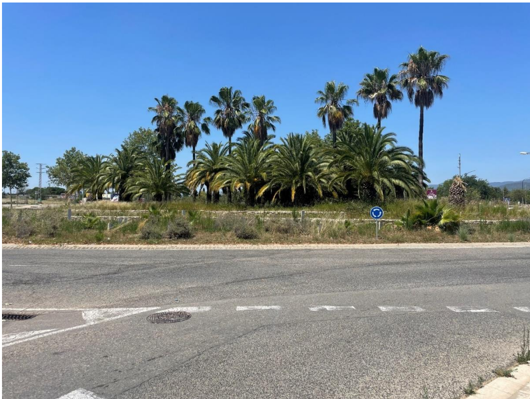
Figura 35. Vista del estado actual del interior de la rotonda desde el Carrer de la Mare de Déu del Pilar.
