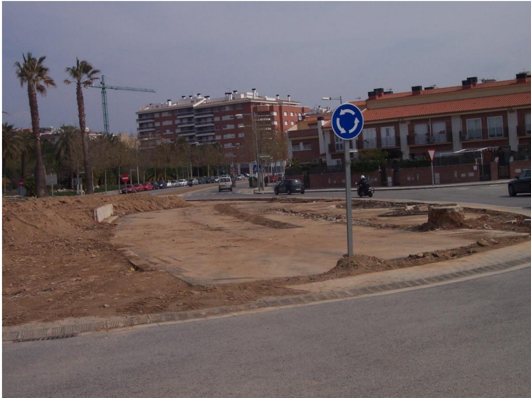
Figura 2. Movimientos de tierras donde se aprecia el trazado de la carretera previa sobre la que se construyó la rotonda. Ajuntament de Reus.
