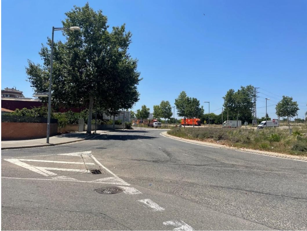
Figura 34. Entrada y salida de la rotonda por el Carrer de la Mare de Déu del Pilar donde se pueden observar el imbornal EM1185692 y el pozo de la red de saneamiento PO015339.
