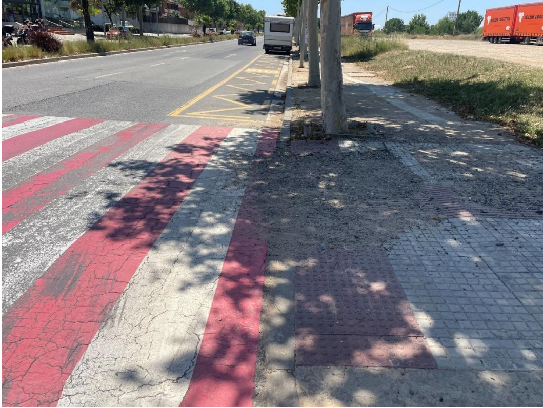
Figura 47. Acumulación de sedimentos en la acera a la altura del paso de cebra peraltado.
