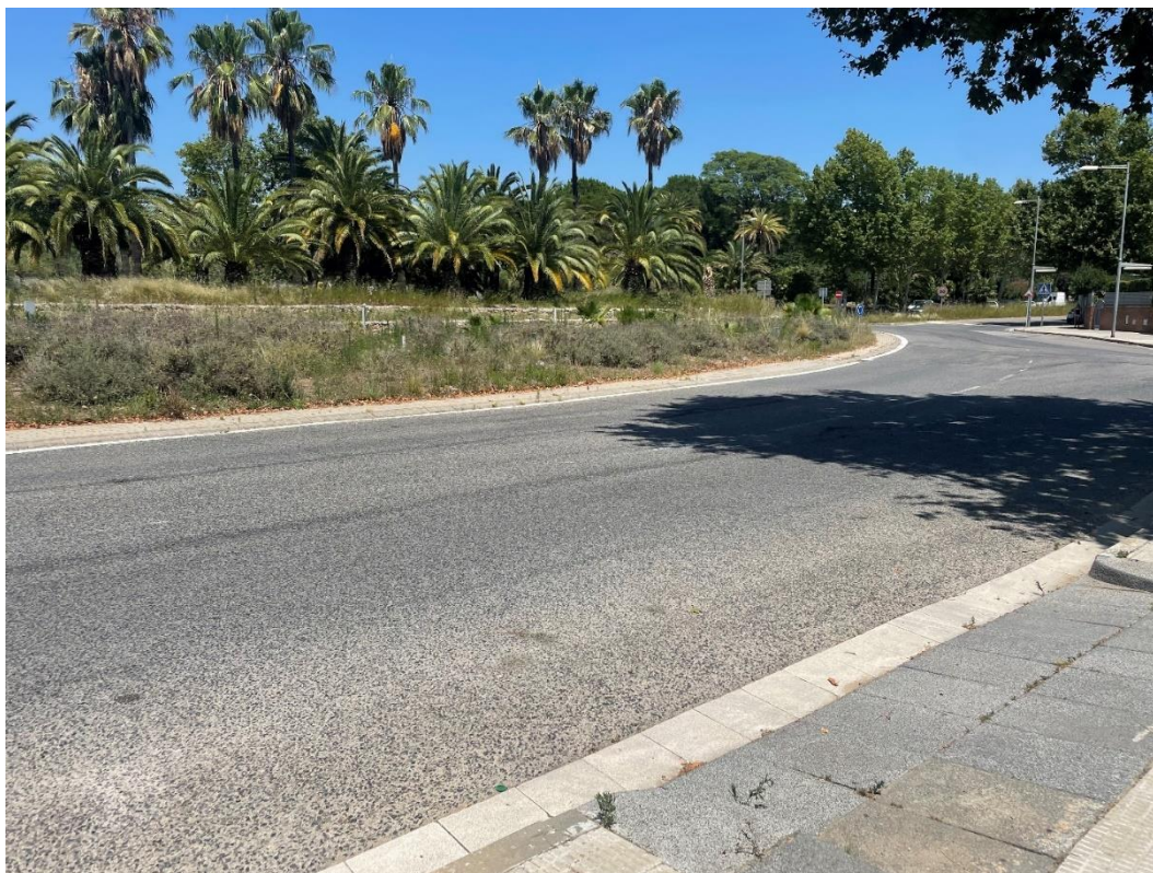
Figura 40. Detalle de rampa de conexi6n del camino a la rotonda.
