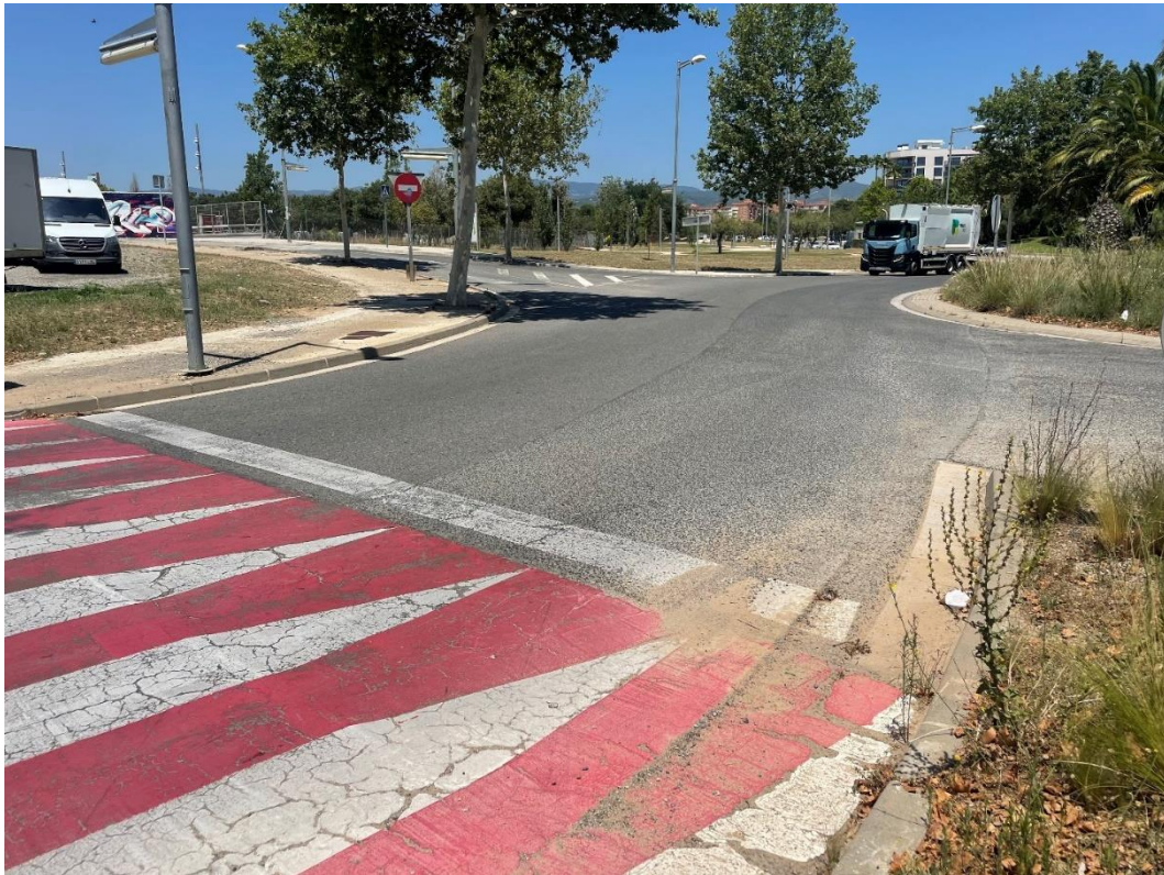
Figura 45. Salida de la rotonda por la zona Suroeste hacia la Avinguda de Riudoms donde se aprecia el paso de cebra peraltado existente y una acumulaci3n de finos en el margen de la carretera junto a la mediana.
