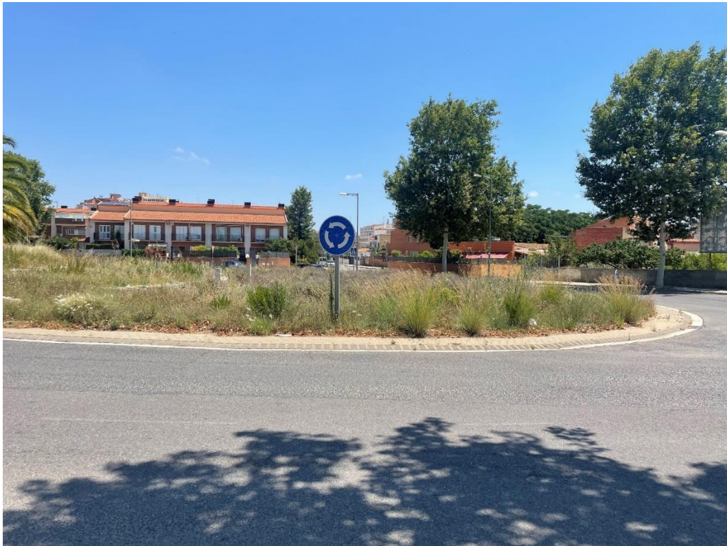
Figura 51. Vista del interior de la rotonda desde la conexión con el Camí del Roquís.
