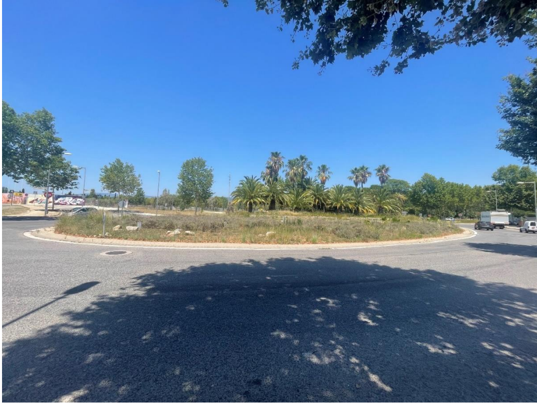
Figura 42. Vista panorámica del interior de la rotonda.
