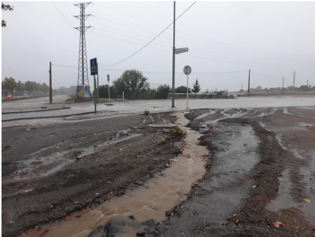
Figura 10. Entrada a rotonda de Camí del Roquís. Se puede apreciar el arrastre de sedimentos y la rodera creada por la escorrentía. Ajuntament de Reus.
