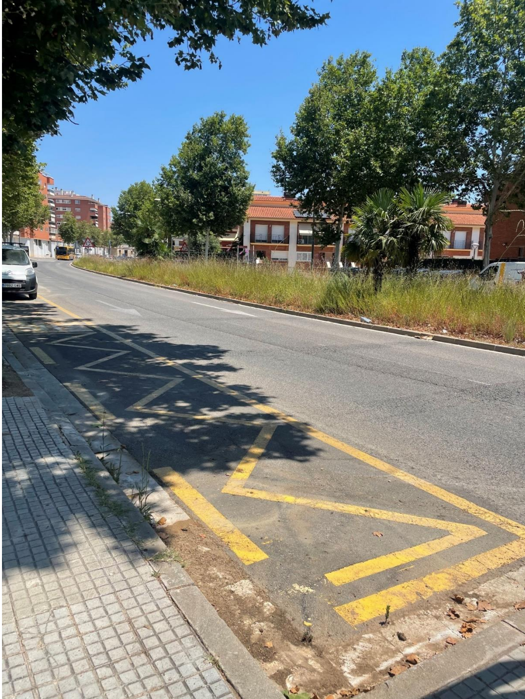
Figura 29. Detalle del arrastre de sedimentos de la Avinguda de Riudoms.
