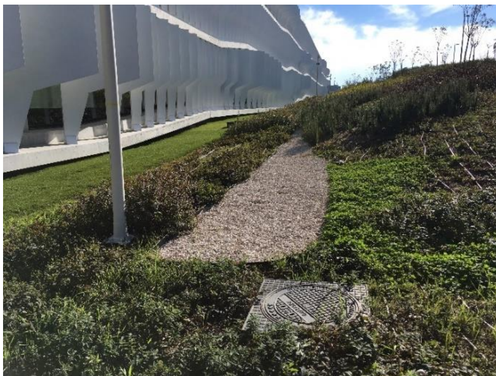
Figura 3. Ejemplo de un dren filtrante en Madrid-ES.
