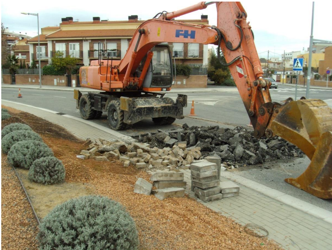
Figura 8. Demolición de carretera y rigola. Ajuntament de Reus.
