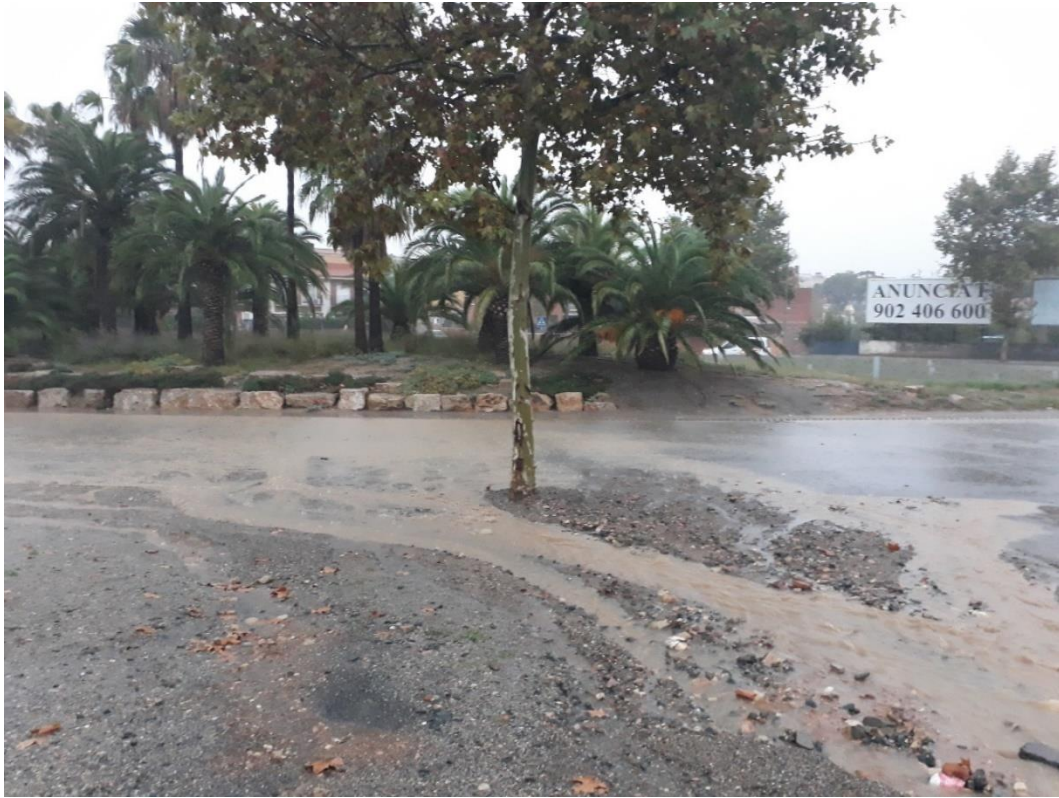
Figura 11. Prolongación de la rodera que encausa la escorrentía y detalle de los sedimentos arrastrados. Ajuntament de Reus.
