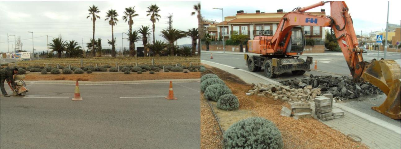
Figura 9. Labores de reparación en los viarios de la rotonda. Fuente: Ajuntament de Reus.
