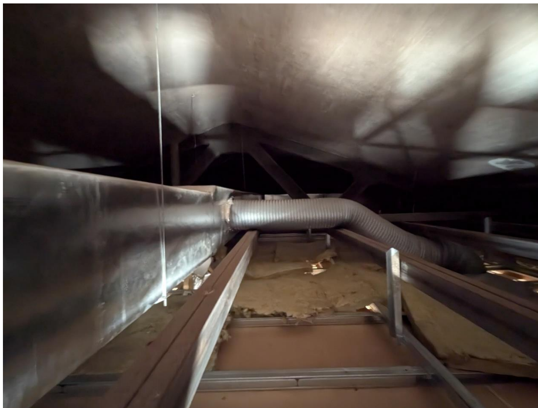
Cala 1. Cara inferior enguixada de la coberta i pas dels elements del sistema de calefacció per sobre del fals sostre de la sala polivalent. Al fons, una de les encavallades de formigó (font: l'autor del projecte. Agost 2024).
