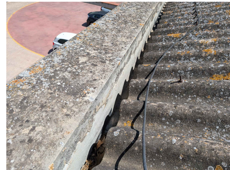
Canaló per a evacuació d'aigües de la vessant nord
