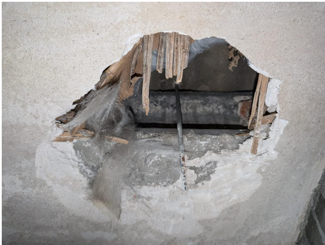
Cala 2. Composició de la subestructura formada per biguetes de formigó de doble "T" amb un entrebigat de canyís i aïllant de fibres de vidre. També es pot veure la vareta de ferro en "L" que subjecta les plaques de fibrociment a les biguetes. (font: l'autor del projecte. Agost 2024).
