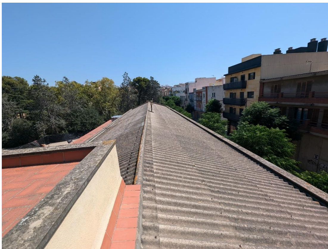
Coberta de fibrociment a substituir (font: l'autor del projecte. Agost 2024).
