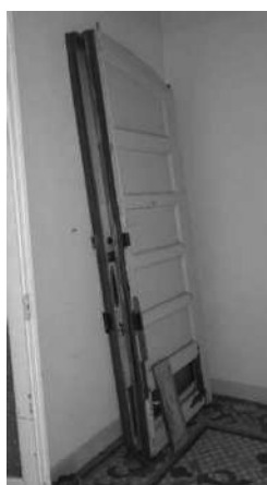
Porta principal trencada, guardada a l'interior
