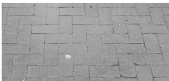
Paviment ceràmic planta sota-coberta
