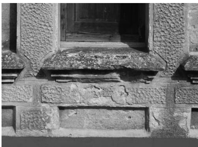
Façana de la planta sotacoberta des de la terrassa
