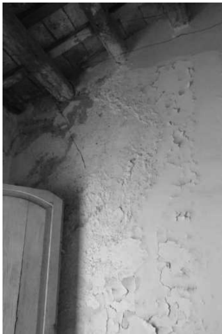
Interior del mur de façana de la planta sota-coberta
