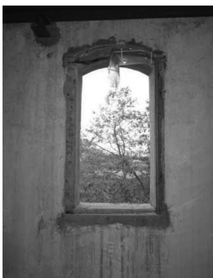
Obertura sense fusteria (pl. sotacoberta)
