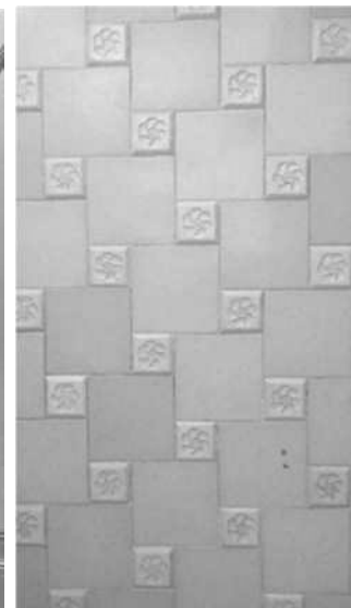
Enrajolat bany de planta 1
