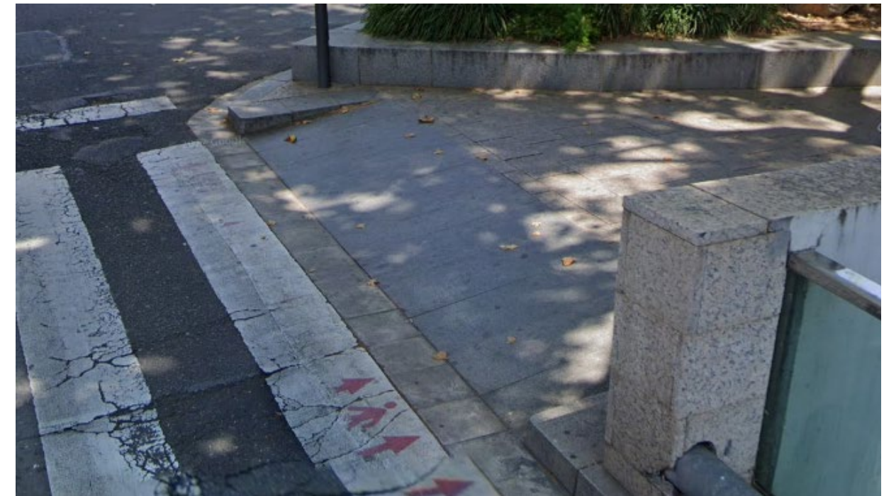
Figura 16. Exemple de gual prefabricat amb pedra granítica a la Plaça del Nen de les Oques de Reus
