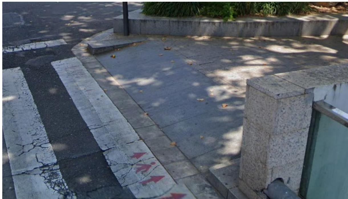
Figura 8. Exemple de gual prefabricat amb pedra granítica a la Plaça del Nen de les Oques de Reus
