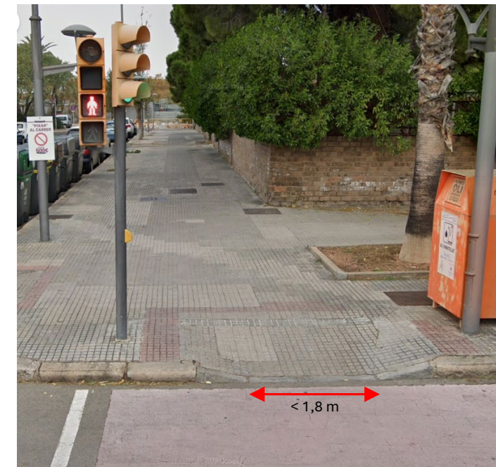
Figura 3. Deficiència d'accessibilitat per a PMR per amplada de gual. Plaça de l'Estació.
