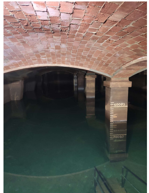
Foto Núm. 4 Sostre de volta catalana dipòsit d'aigua
