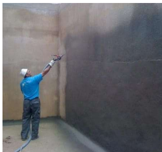
Figura núm.6 Aplicació de LOTUMCEM IMPERSTOP murs
