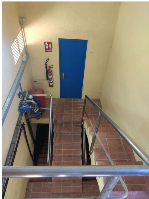
Foto Núm. 3 Escales accés a dipòsit
