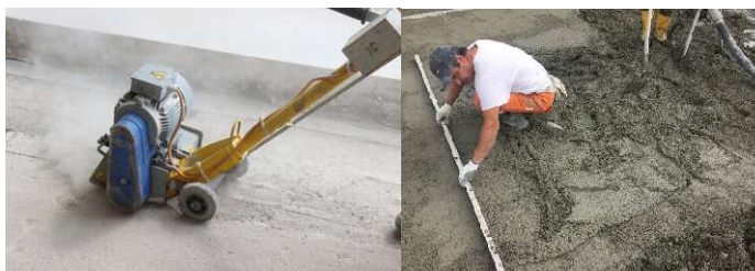
Figura núm.4 Fresat i formació de pendents posterior
