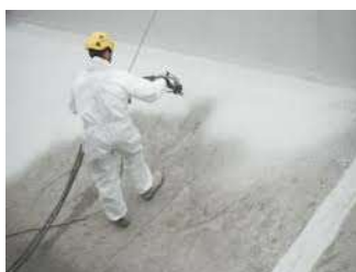
Figura núm.5 Aplicació de LOTUMCEM IMPERSTOP sobre morter de pendents
