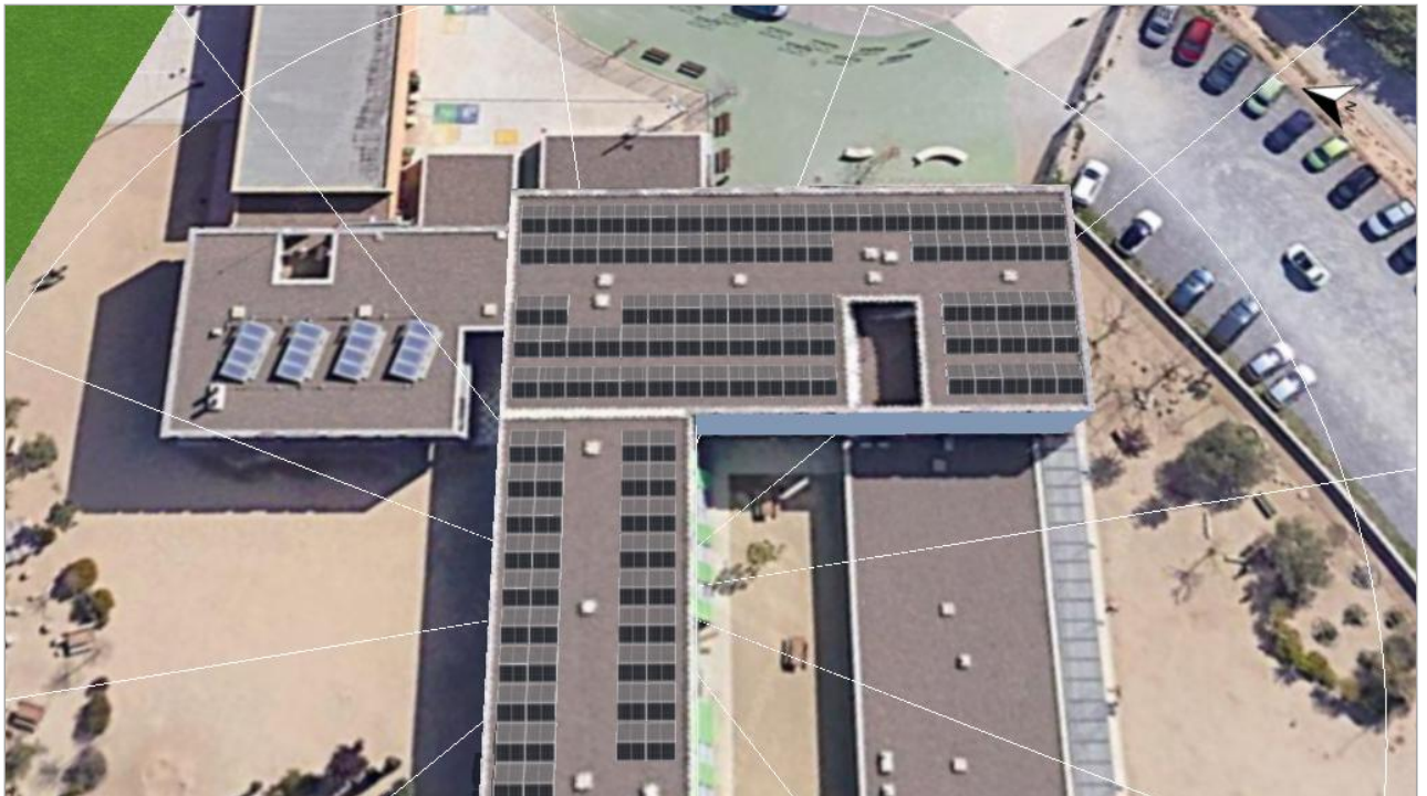
Figura: 1. Superficie fotovoltaica - Edificio a discreción 01-Superficie fotovoltaica Oeste
