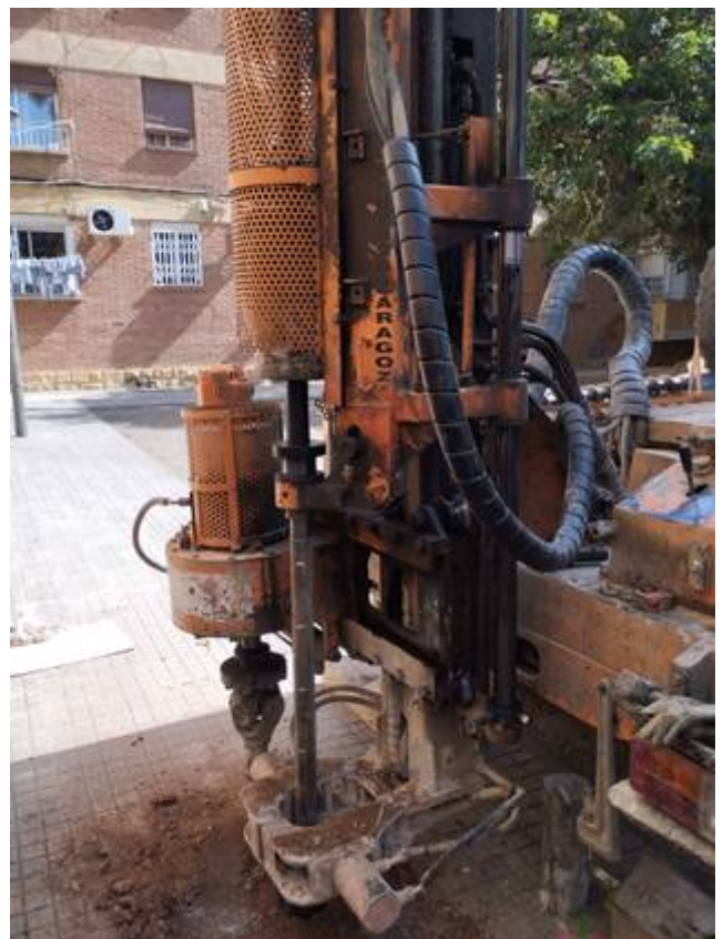
Vistes de quatre dels deu sondeigs realitzats a la parcel·la objecte d'estudi, S-1, S-2, S-3 i S-4 del tipus Rotació helicoidal.
