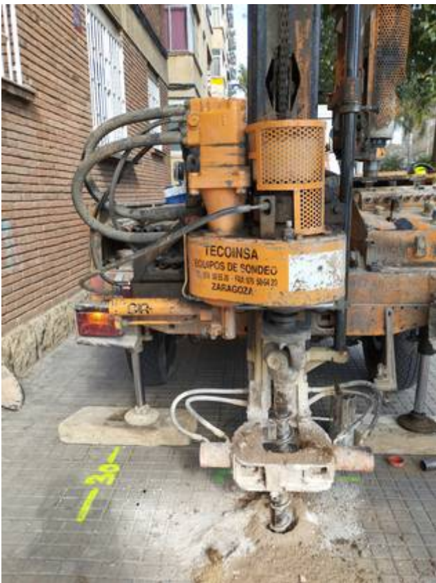
Vistes de quatre dels deu sondeigs realitzats a la parcel·la objecte d'estudi, S-1, S-2, S-3 i S-4 del tipus Rotació helicoidal.
