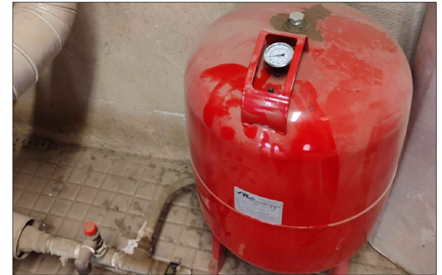
VAS D'EXPANSIÓ DE 100 LITRES EXISTENT
