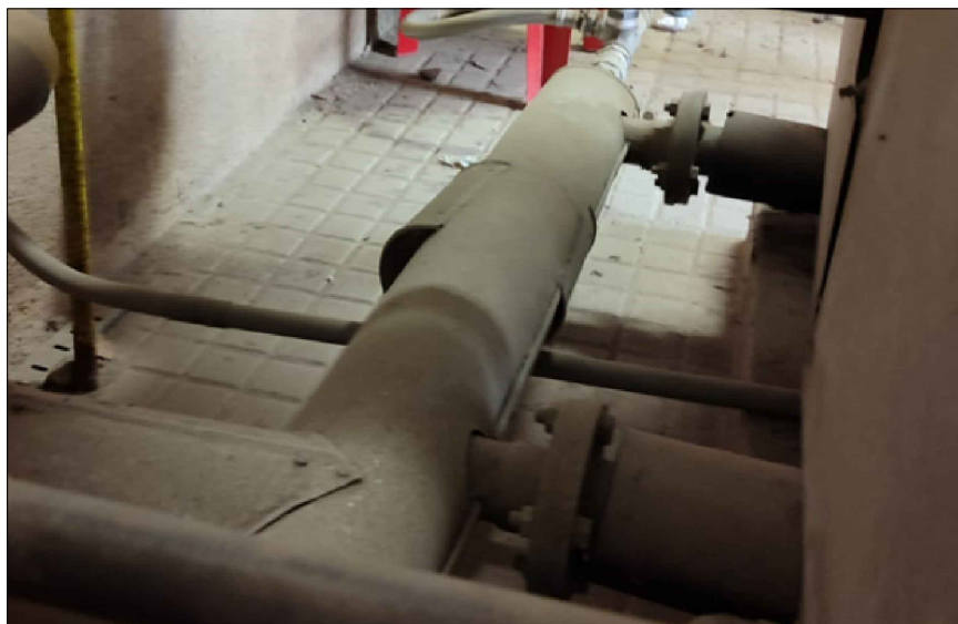
CONNEXIÓ A CALDERES EXISTENTS (PRIMARI)
