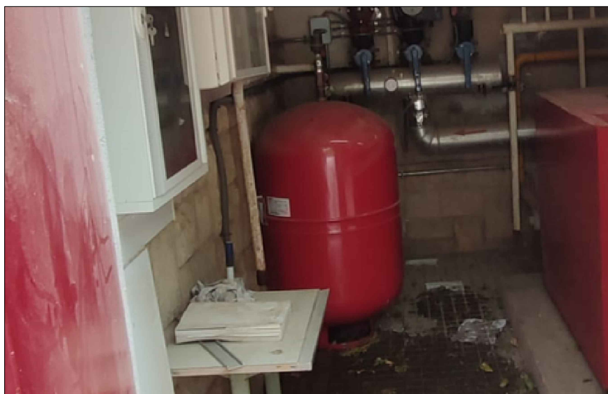
VAS D'EXPANSIÓ DE 300 LITRES EXISTENT
