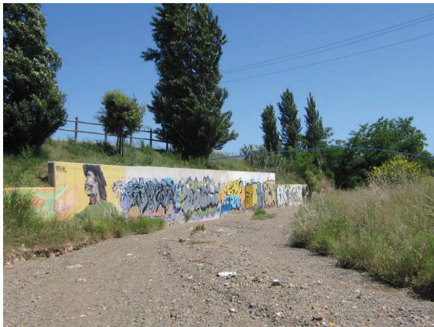
Foto 6. Emplaçament futura passarel·la
