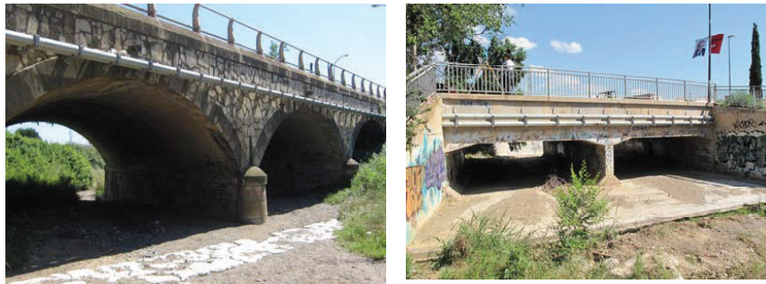
Figura 1: Vista des d'aigües avall de les dos obres de pas: ctra. Montblanc (esquerra) i camí de Valls (dreta)
