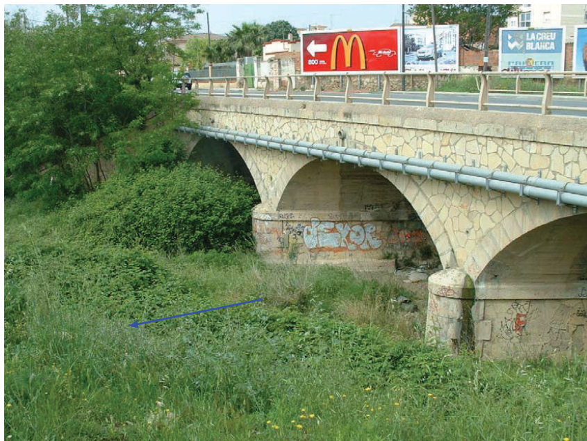
Foto 2. Obra de pas sota la carretera de Montblanc. Límit sector E.2 aigües amunt
