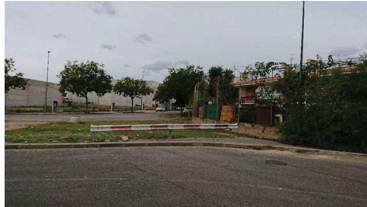
Zona on executar la vorera de la futura rotonda
