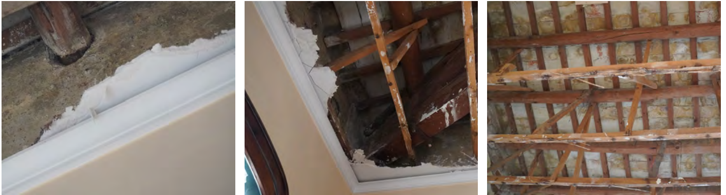
Imatge 014 - Cornissa de guix i fragments del cel ras / Entramat de suport amb restes d'un antic cel ras de canyís / Solera de maó massís emblanquinada
