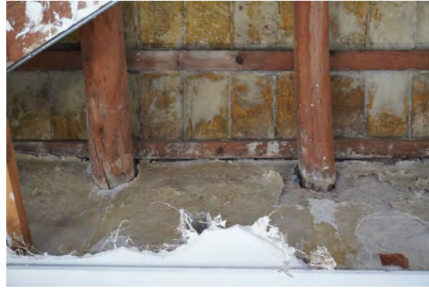
Imatge: F1. Degradació parament. Filtracions i humitat.
