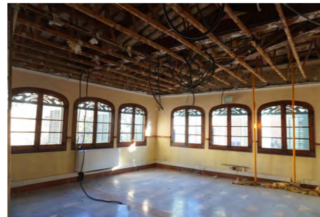
Imatge 6. Sala nord (P2 - àmbit projecte)
