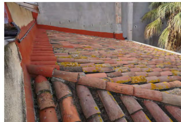
Imatge 3. Impermeabilització amb pintura bituminosa
