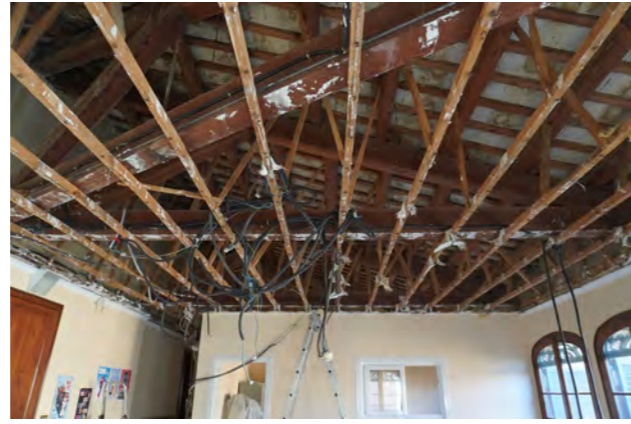
Imatge 2. Sala nord P2. Teulada amb estructura de fusta, llates i tauler de rajols ceràmics . Subestructura de fusta fals sostre enderrocat.
