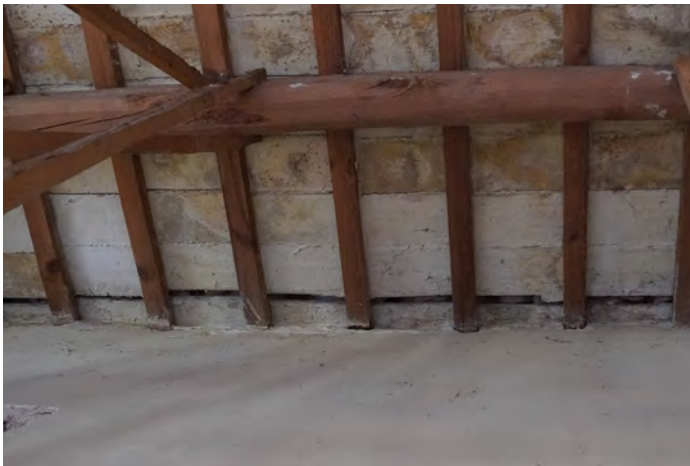
Imatge 023 - Obertura entre entre rajols de la solera per lliscament del tauler ceràmic
