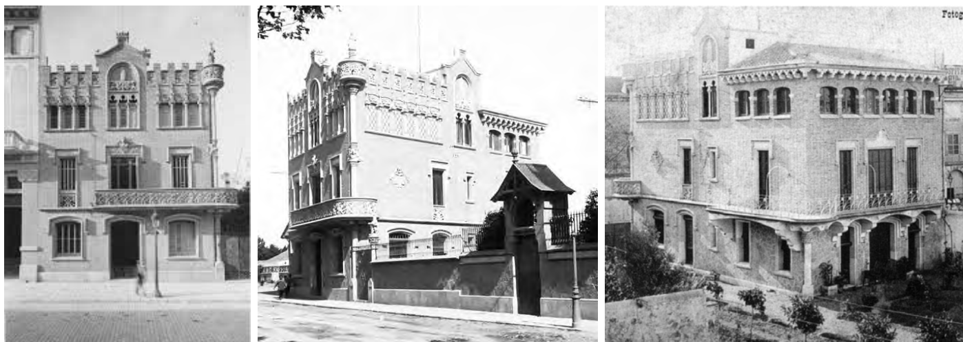
Imatge 001 - Façana del carrer Sant Joan, façana lateral i façana posterior
