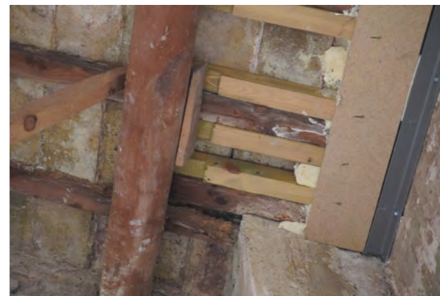
Imatge 4. Intervenció d'urgència caps llates (d-01 - d-12)
