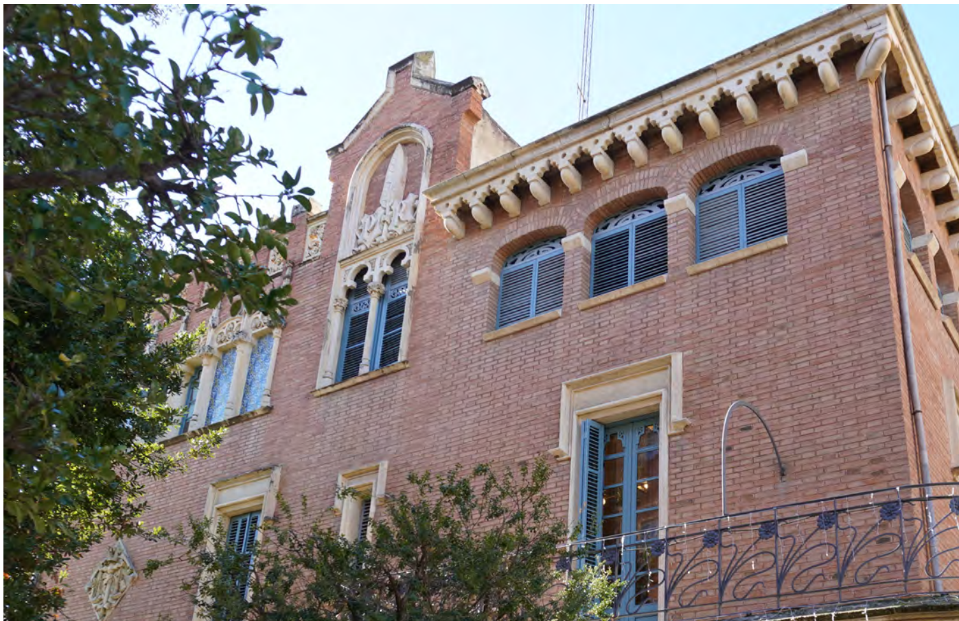
Imatge 007 - Façana lateral
