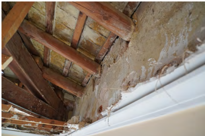
Imatge 020 - Caps encastats als murs de les encavallades, les corretges i les llates
