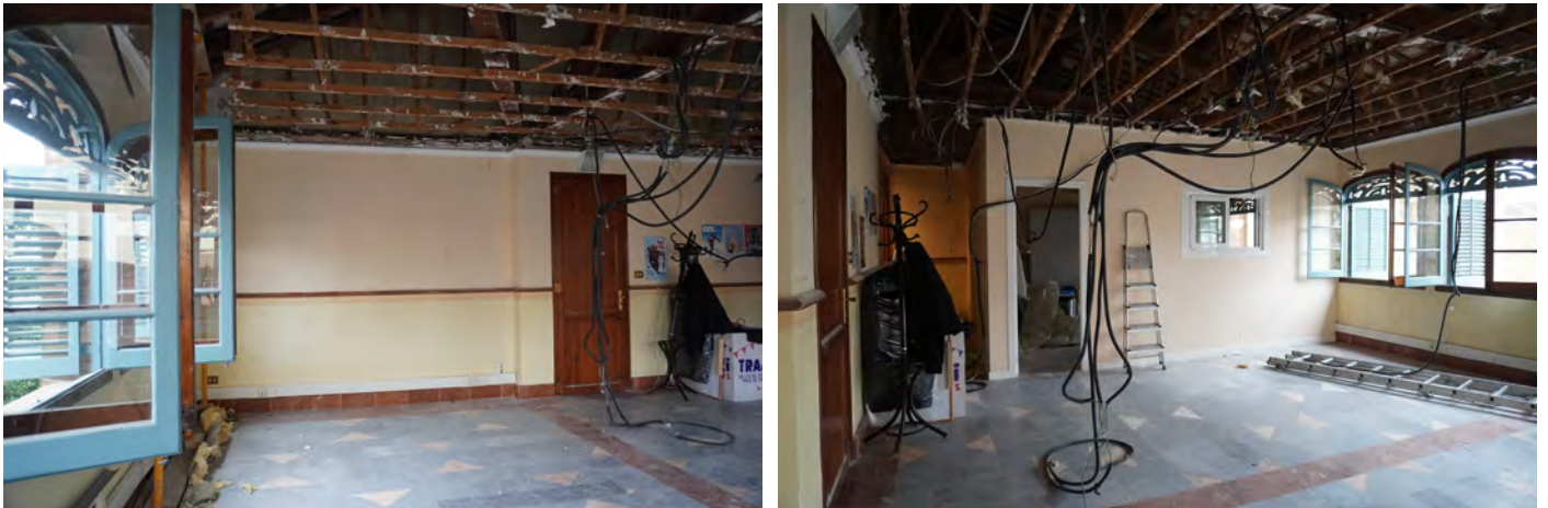
Imatge 015 - Paviment i sòcol (intervenció de 1989); i compartimentació interior d'envans lleugers (Intervenció posterior)
