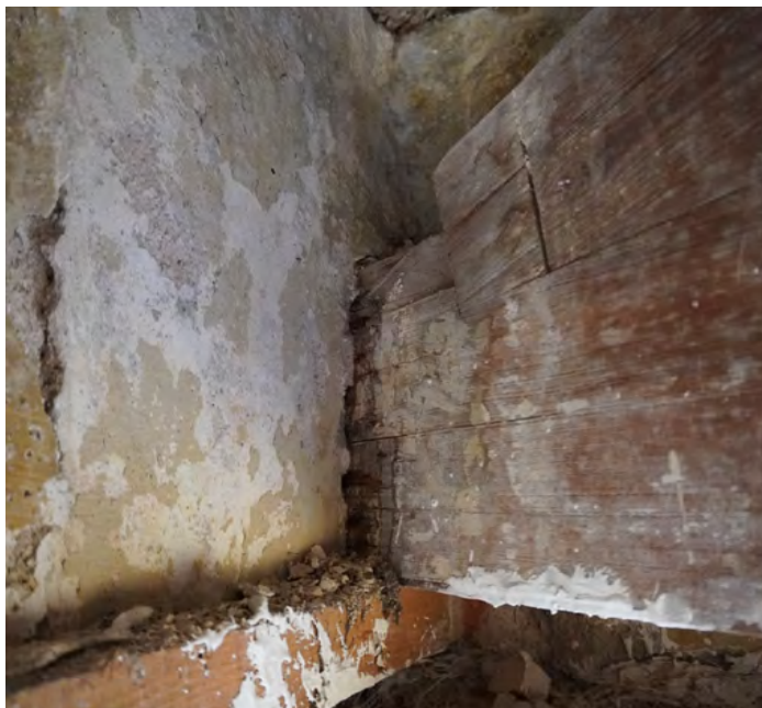
Imatge 021 - Cap d'una encavallada i cap d'una corretja encastats al mur de façana
