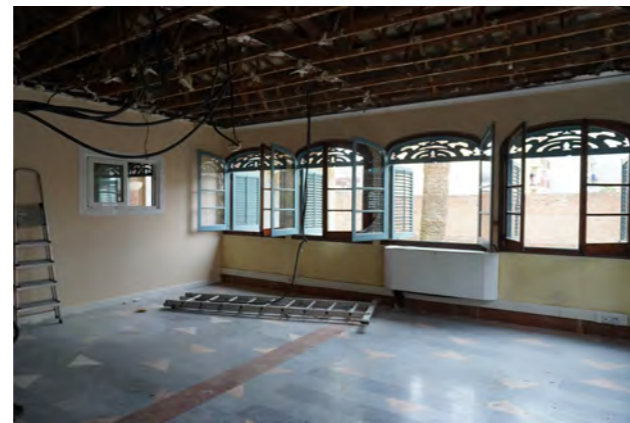
Imatge 5. Sala nord (P2 - àmbit projecte)
