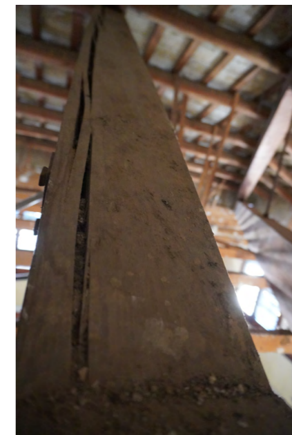
Imatge 4. Clivelles tornapunts encavallades II i III, reomplir amb resines d'epòxid.
