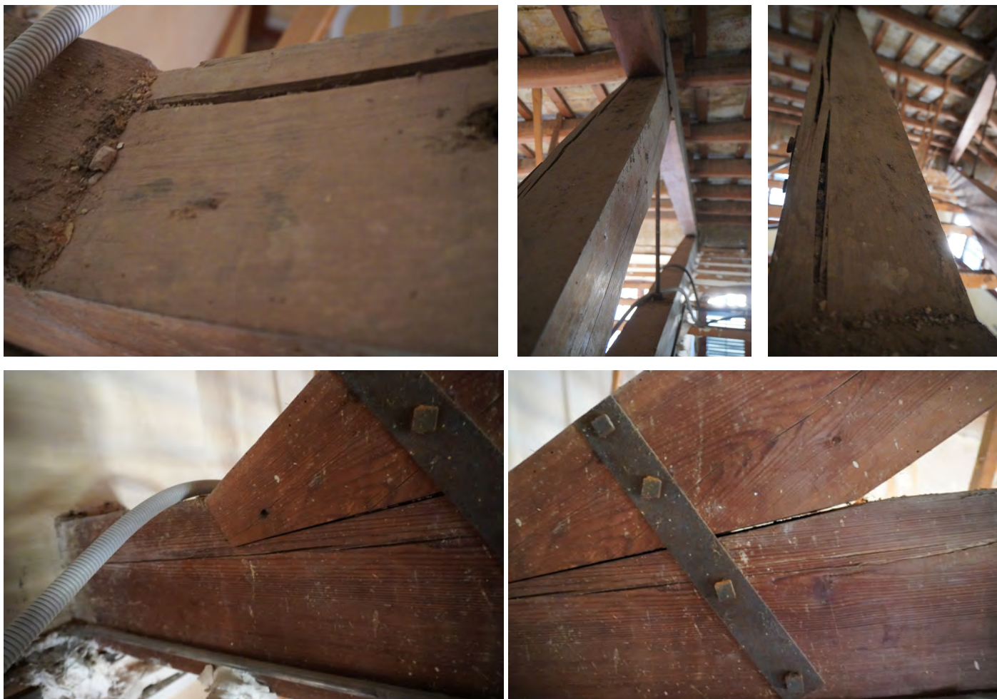
Imatge 026 - Clivelles al tirant i al tornapunts de l'encavallada
