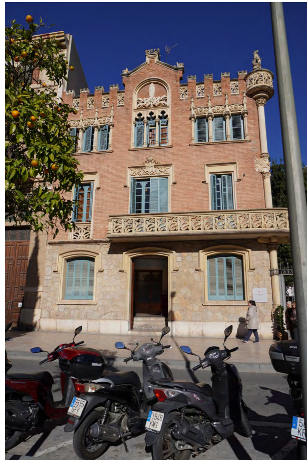
Imatge 1. Façana sud (carrer Sant Joan)
