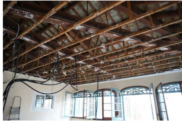
Imatge 1. Sala nord P2. Teulada amb estructura de fusta, llates i tauler de rajols ceràmics . Subestructura de fusta fals sostre enderrocat.
