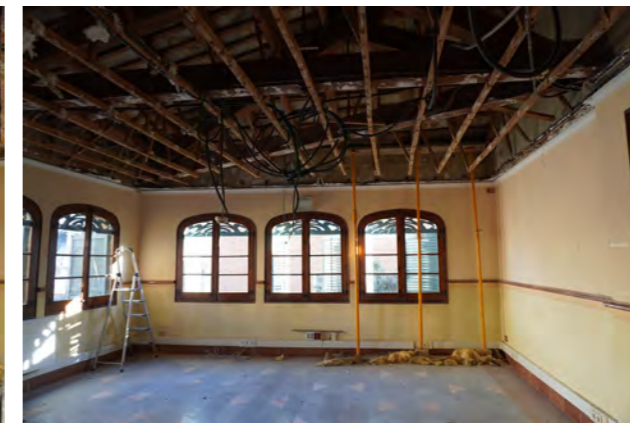
Imatge 7. Sala nord (P2 - àmbit projecte)
