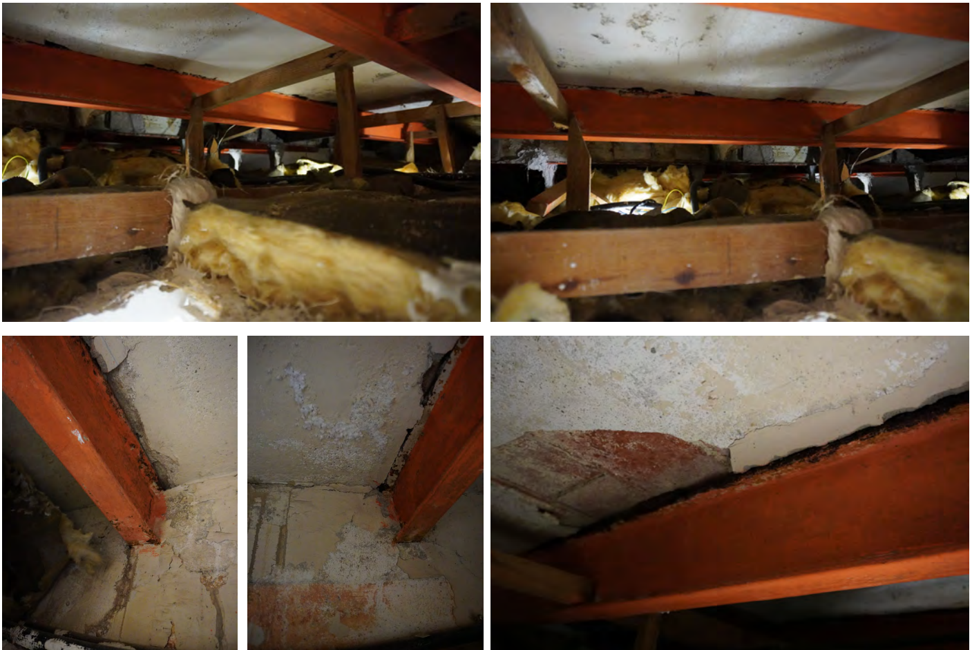
Imatge 033 - Sostremort de la zona amb coberta plana
