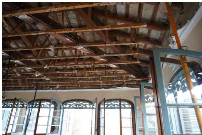
Imatge 013 - Estructura de la teulada: encavallades i corretges de fusta, llates de fusta i solera ceràmica de maó massís; i entramat de fusta de suport del cel·ras
