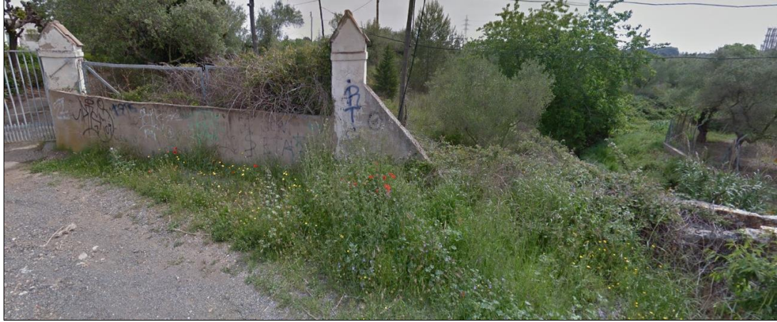
Figura núm.4: Tanca d'obra de delimitació amb la parcel·la que realitzarà les funcions de mirador.
