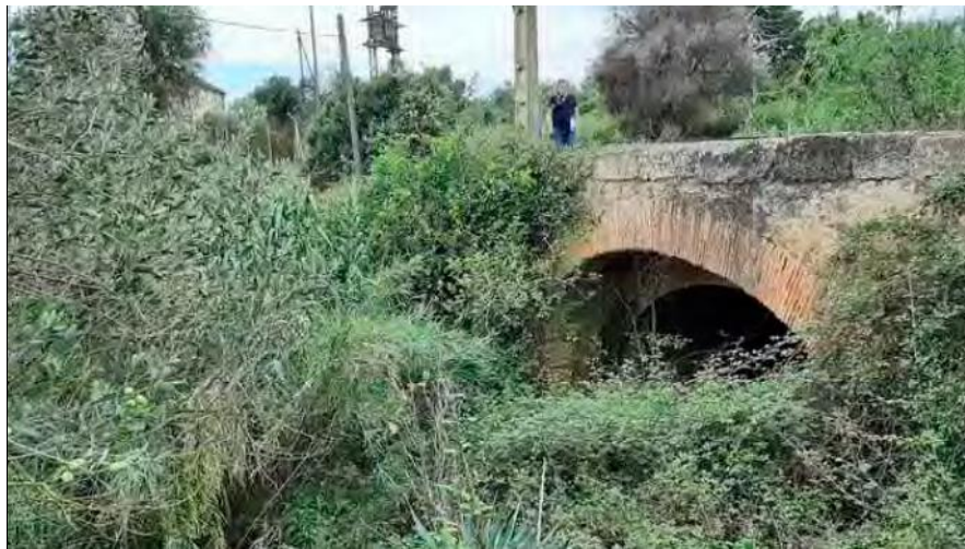
Figura núm.5: Vista del Pont de Calderons des de la nova zona del mirador.
