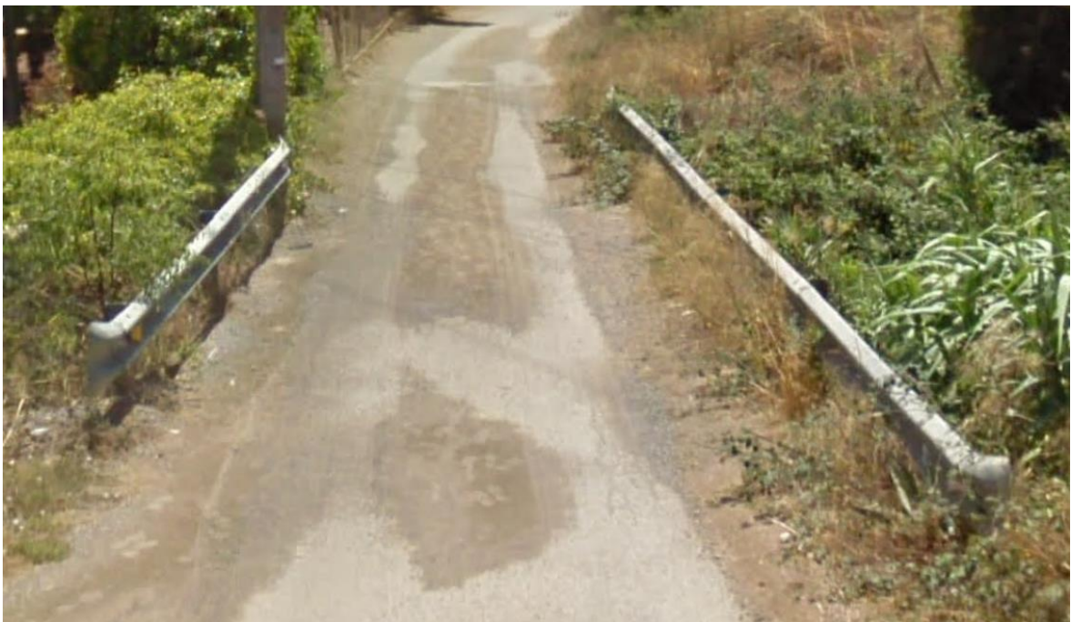
Figura núm.3: Pont de Calderons. Tauler de DTS i tanca metàl·lica.
