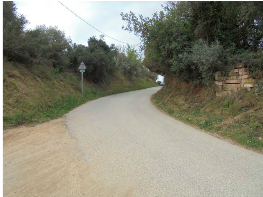
Camí de la Selva costat sud previ a l'encreuament amb riera de l'Abeurada
