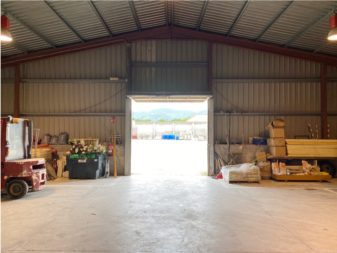
L'interior del magatzem, accés principal a la façana nord.
