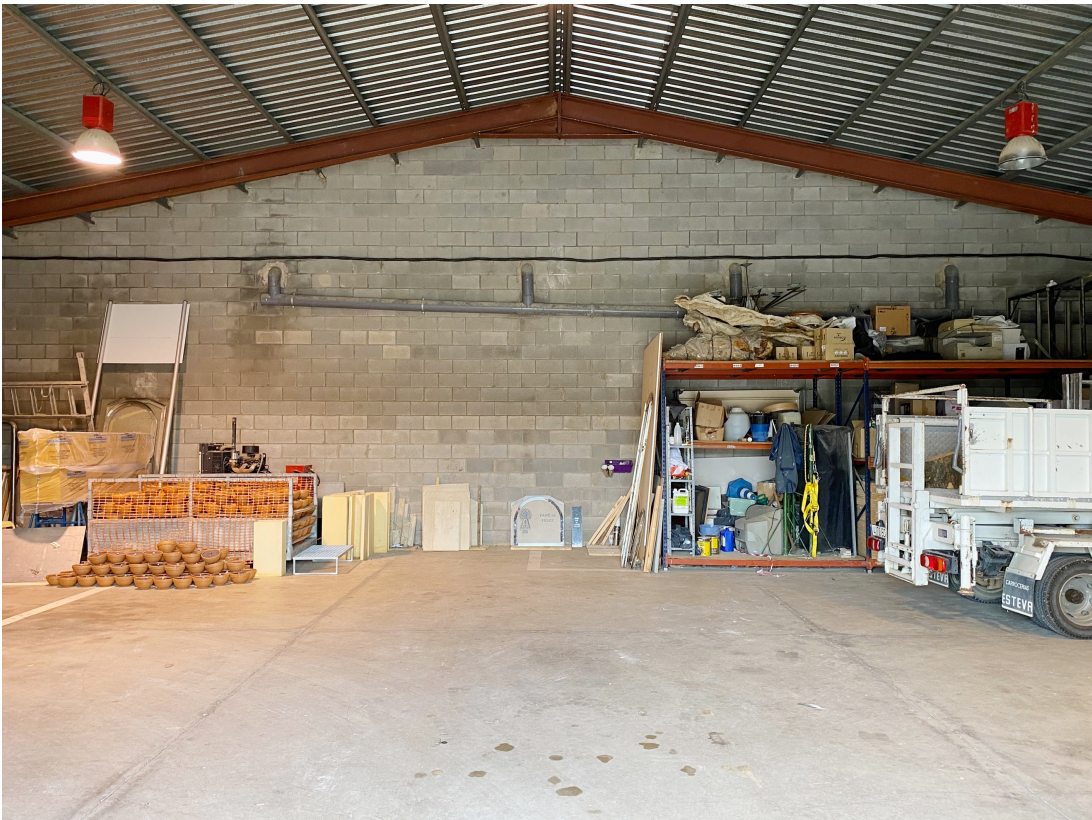
Fons del magatzem a la banda sud, on limita amb un cos de nínxols. Els baixants que s'aprecien són les recollides d'aigües pluvials d'aquests nínxols.
