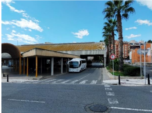
Accessos interns dels autobusos.
