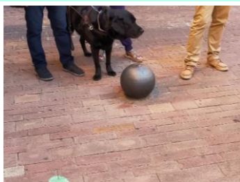
Bollard poc visible al C/ Sant Lluís
