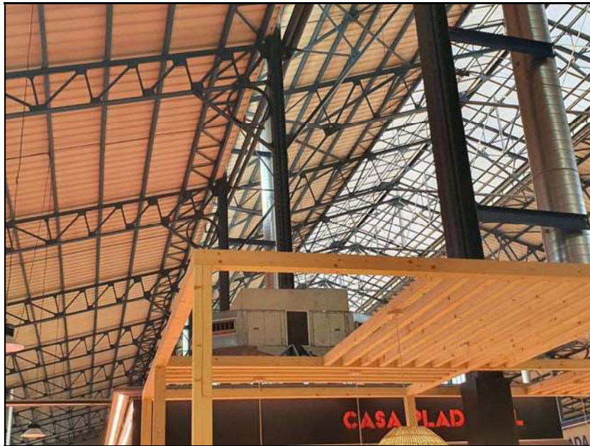
Fotografia 4. Estructura de subjecció coberta nau principal zona central.
