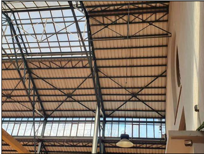
Fotografia 5. Estructura de subjecció coberta nau principal encavallades centrals.
