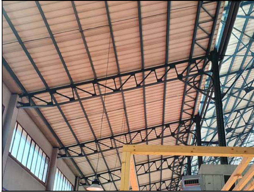
Fotografia 3. Estructura de subjecció coberta nau principal lateral Est.
