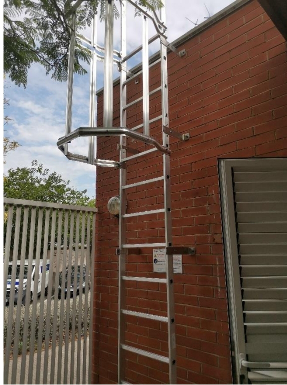
Escala existent d'accés a la coberta
