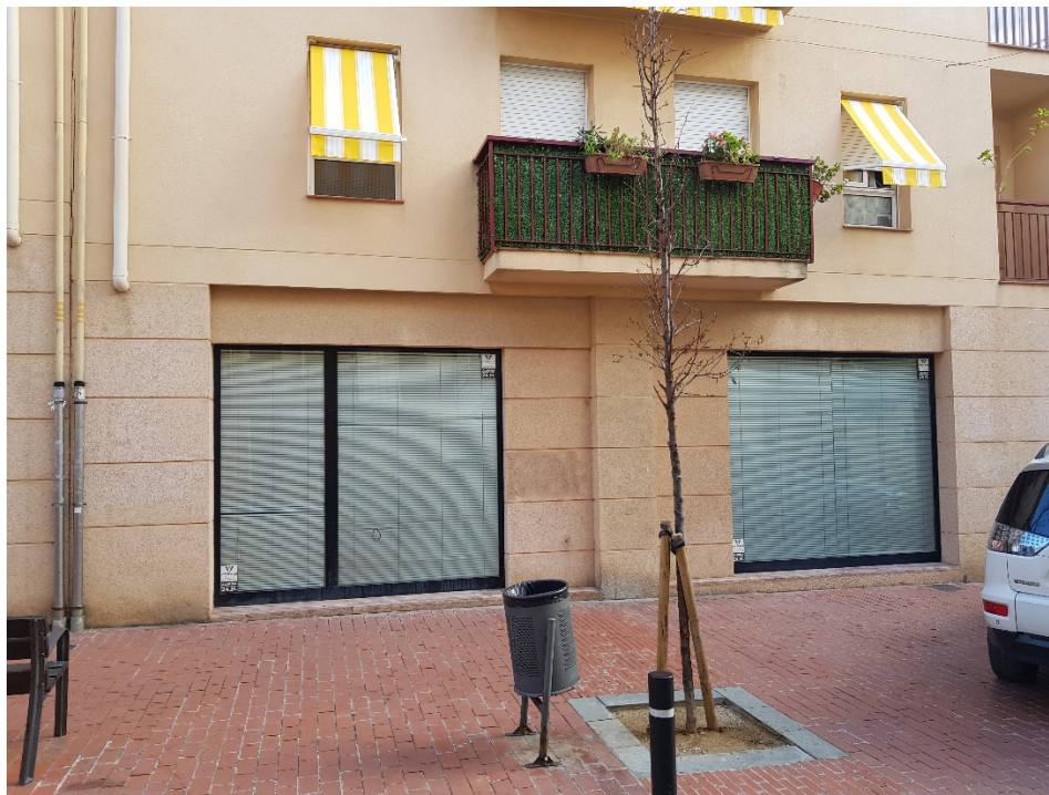
Estat actual de la façana
