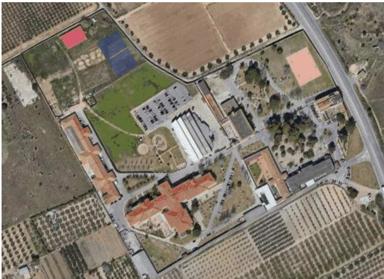
Fotografia 1) Situació de la instal·lació solar dins del complex sanitari
