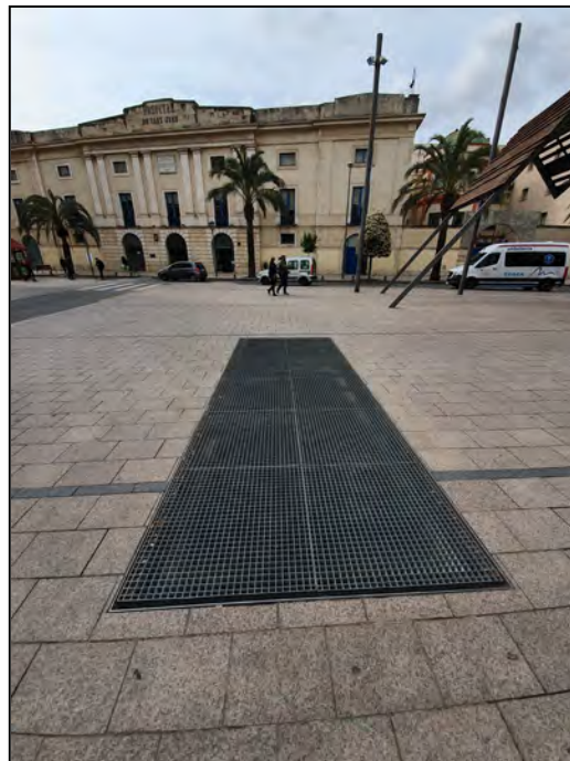
Foto 6. Impulsió aparcament soterrat
