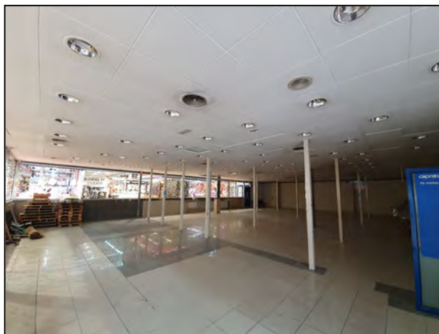
Foto 1. Estat actual de l'espai a la façana principal. El nivell de paviment és lleugerament inferior al del Mercat.
