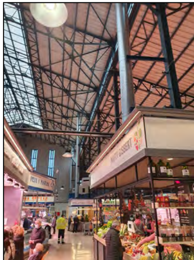
Foto 10. Xemeneies d'extracció de fums existents
