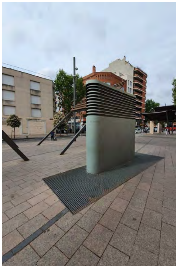
Foto 17. Xemeneia extracció de fums ubicada a la plaça
