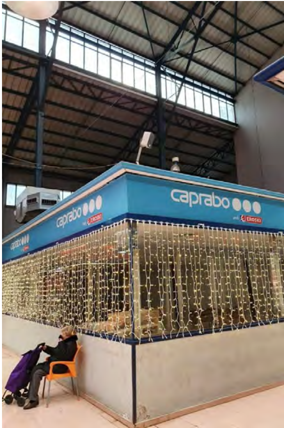
Foto 3. Espai interior per arranjar vist des del passadís interior del mercat
