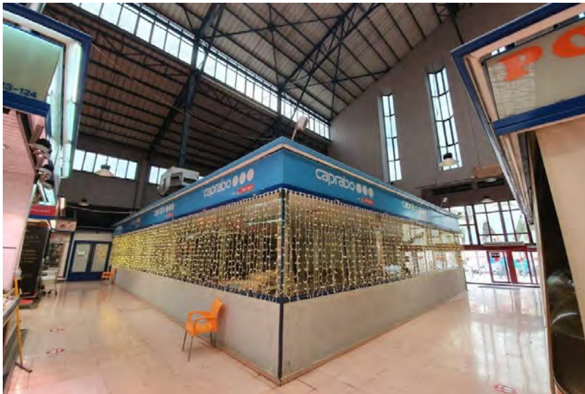
Foto 5. Espai interior per arranjar vist des del passadís interior del mercat
