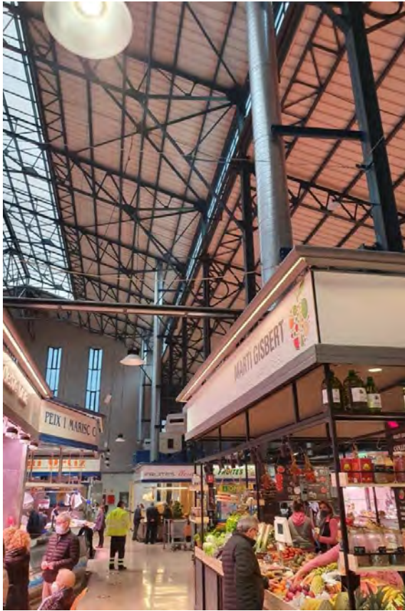
Foto 22. Xemeneies per extracció de fums de les parades
