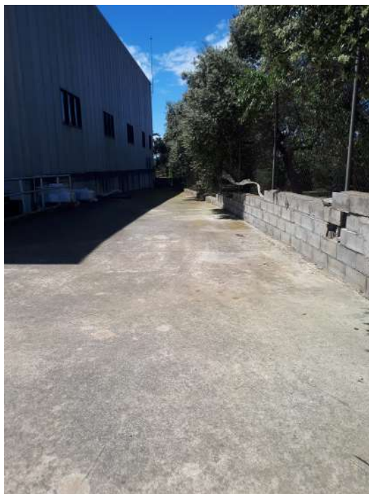
Figura 11. Tram de pati exterior a la zona edifici filtres premsa, on passarà la nova canalització
