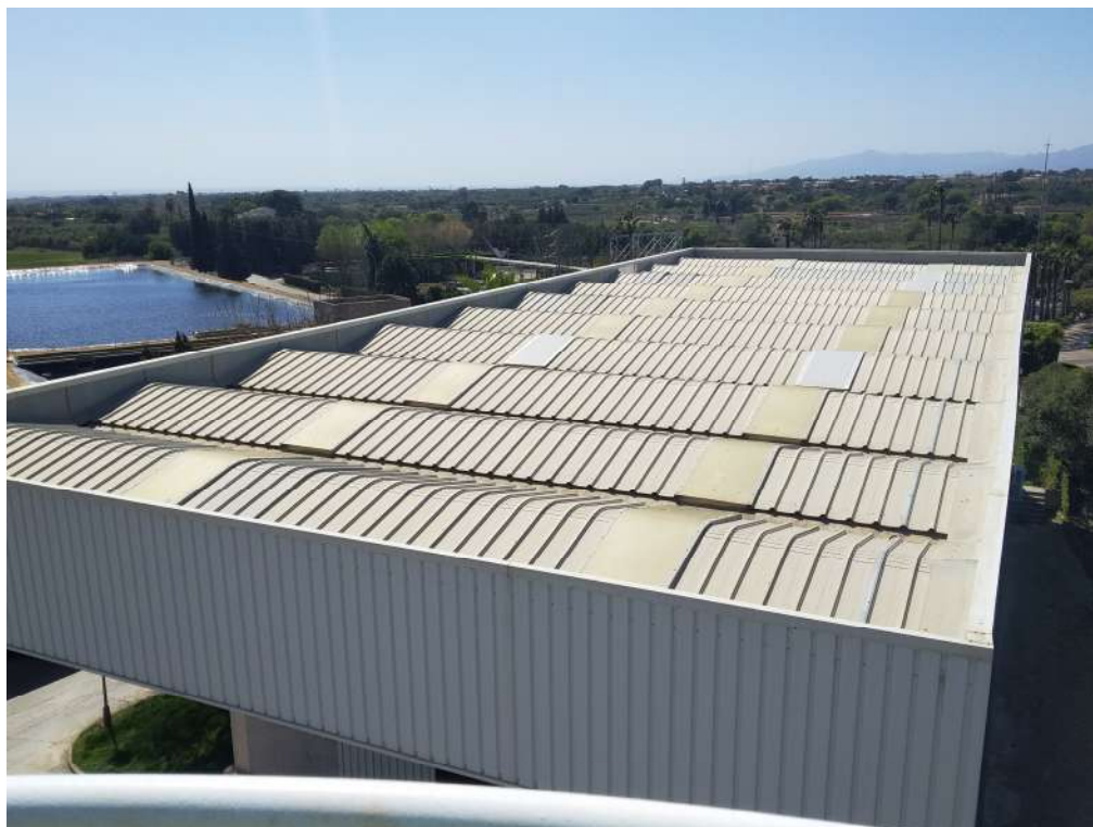
Figura 5. Edifici filtres premsa
