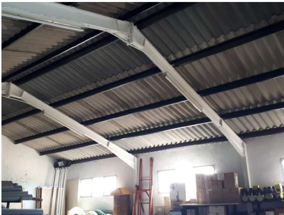
Figura 9. Interior del magatzem del descampat, amb la teulada de fibrociment a substituir
