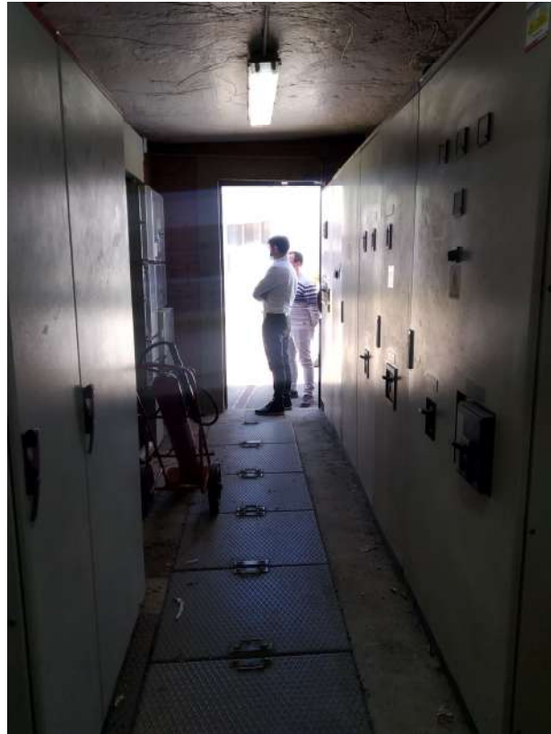
Figura 13. Vista interior del recinte CCM
