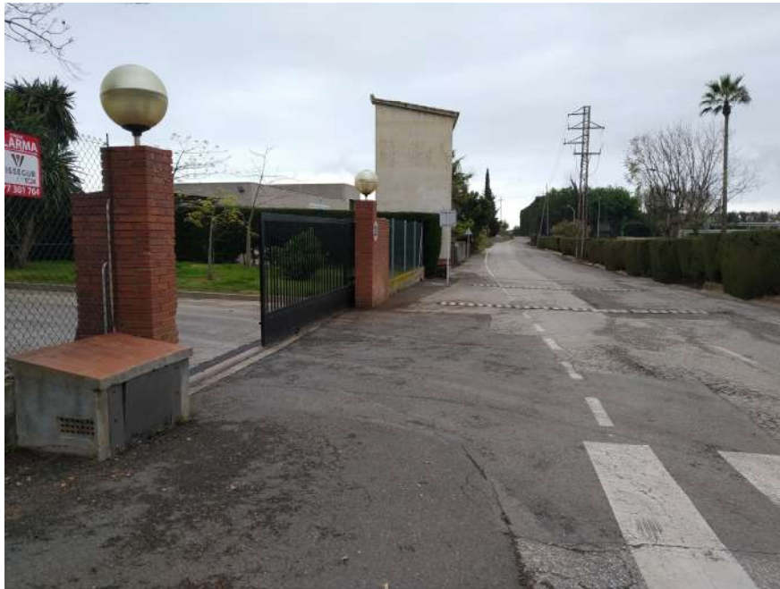
Figura 1. Accés i entrada a l'EDAR de Reus.
