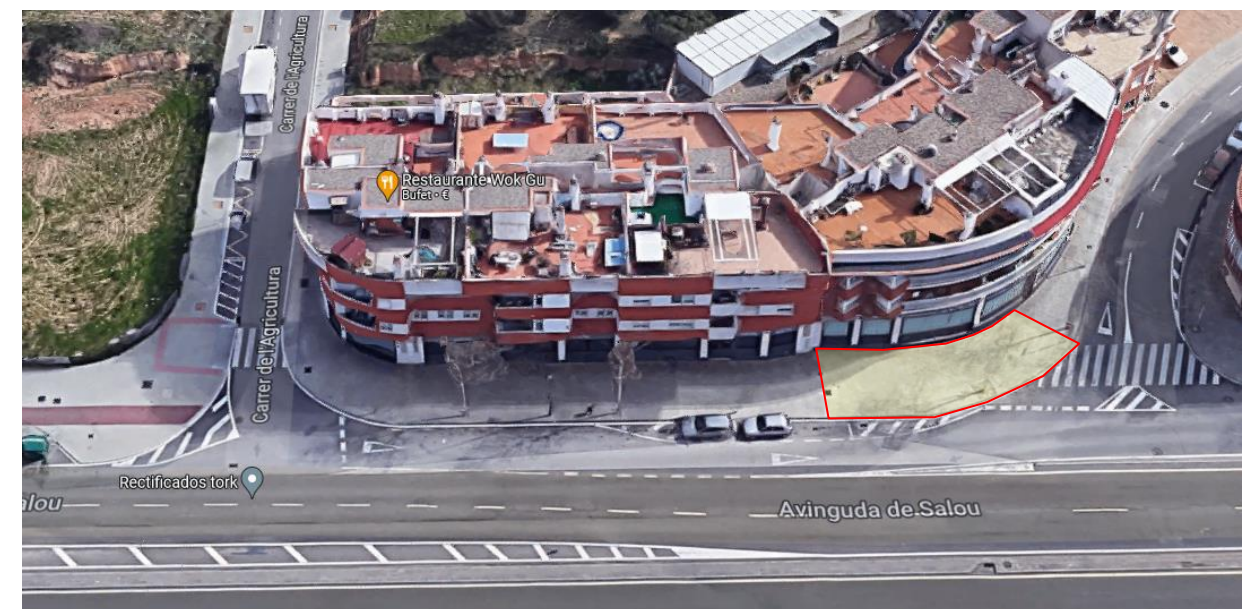
Figura 12. Paviment per a vianants a reparar. Tram 1.
