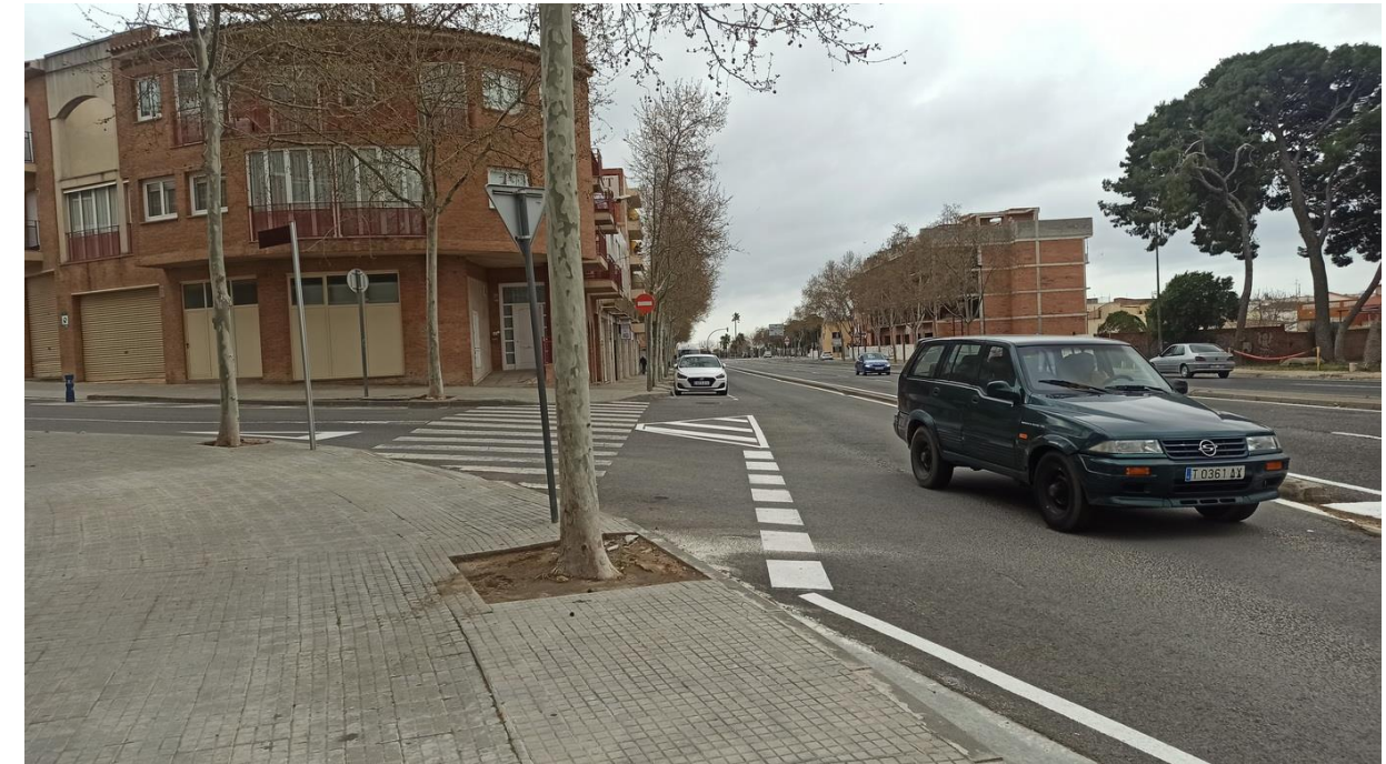
Figura 14. Punt on construir 2 nous guals de vianants i bicicletes a la intersecció amb el carrer de l'Agricultura
