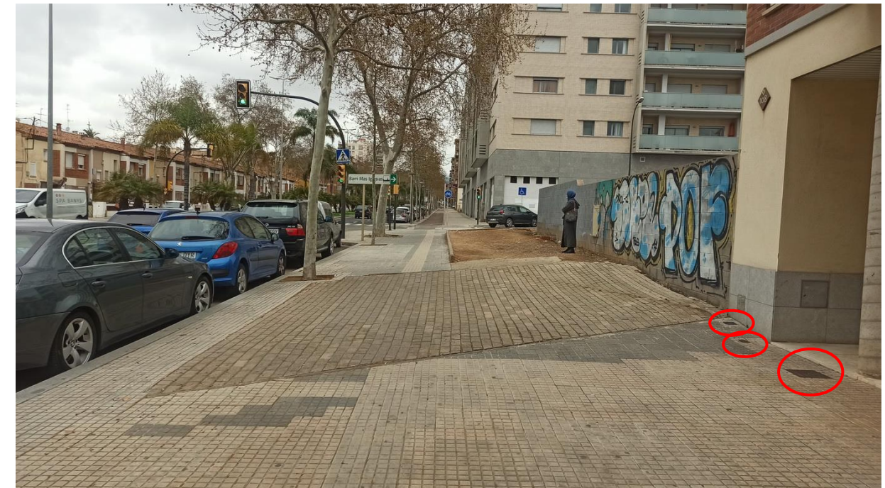
Figura 17. Afectació de pericons a nivellar existents
