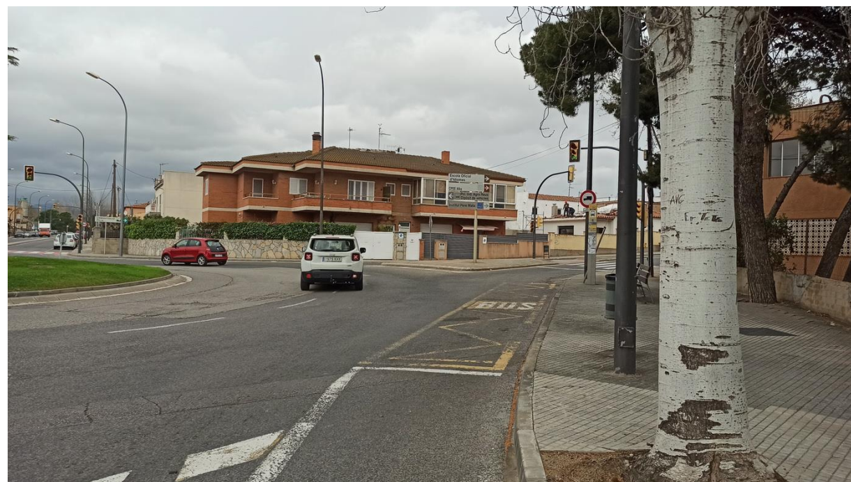
Figura 7. Situació de l'afectació número 2.
