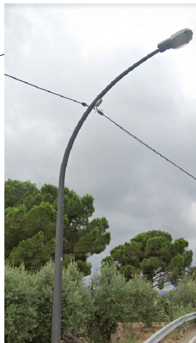
DETALL CABLE FIADOR
