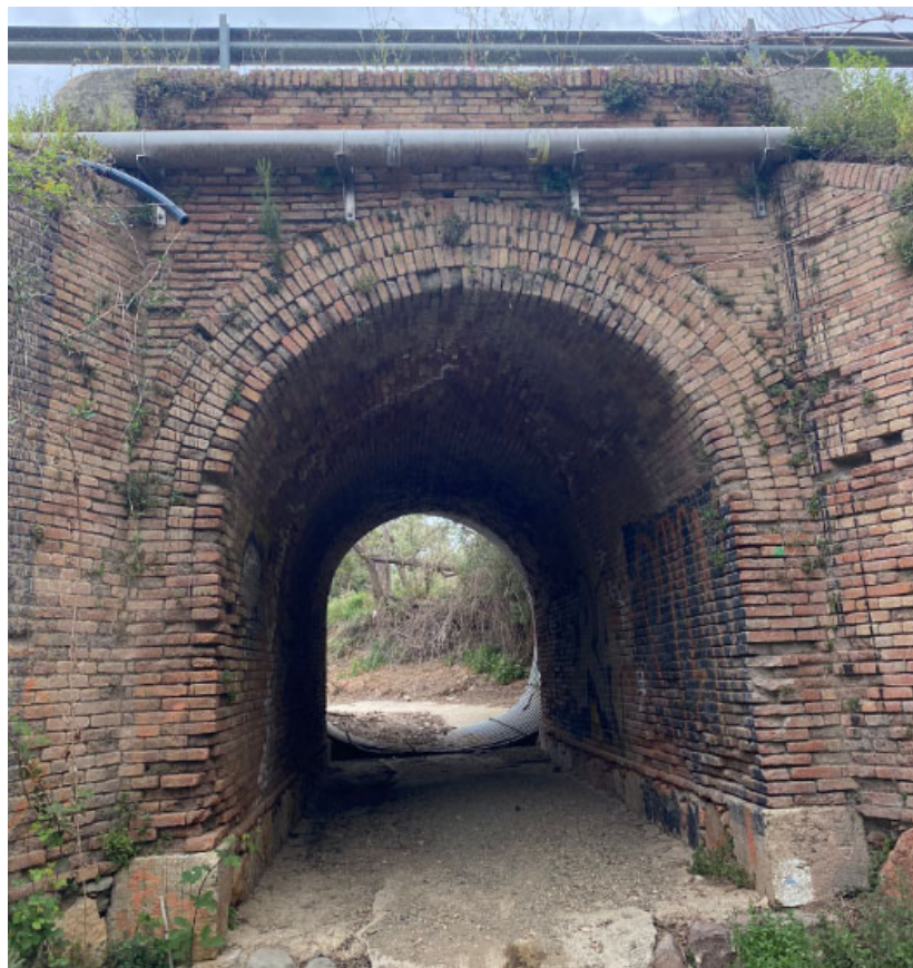
Figura núm.6 Estructura pas inferior de la carretera N-420a i pas de la canonada existent
