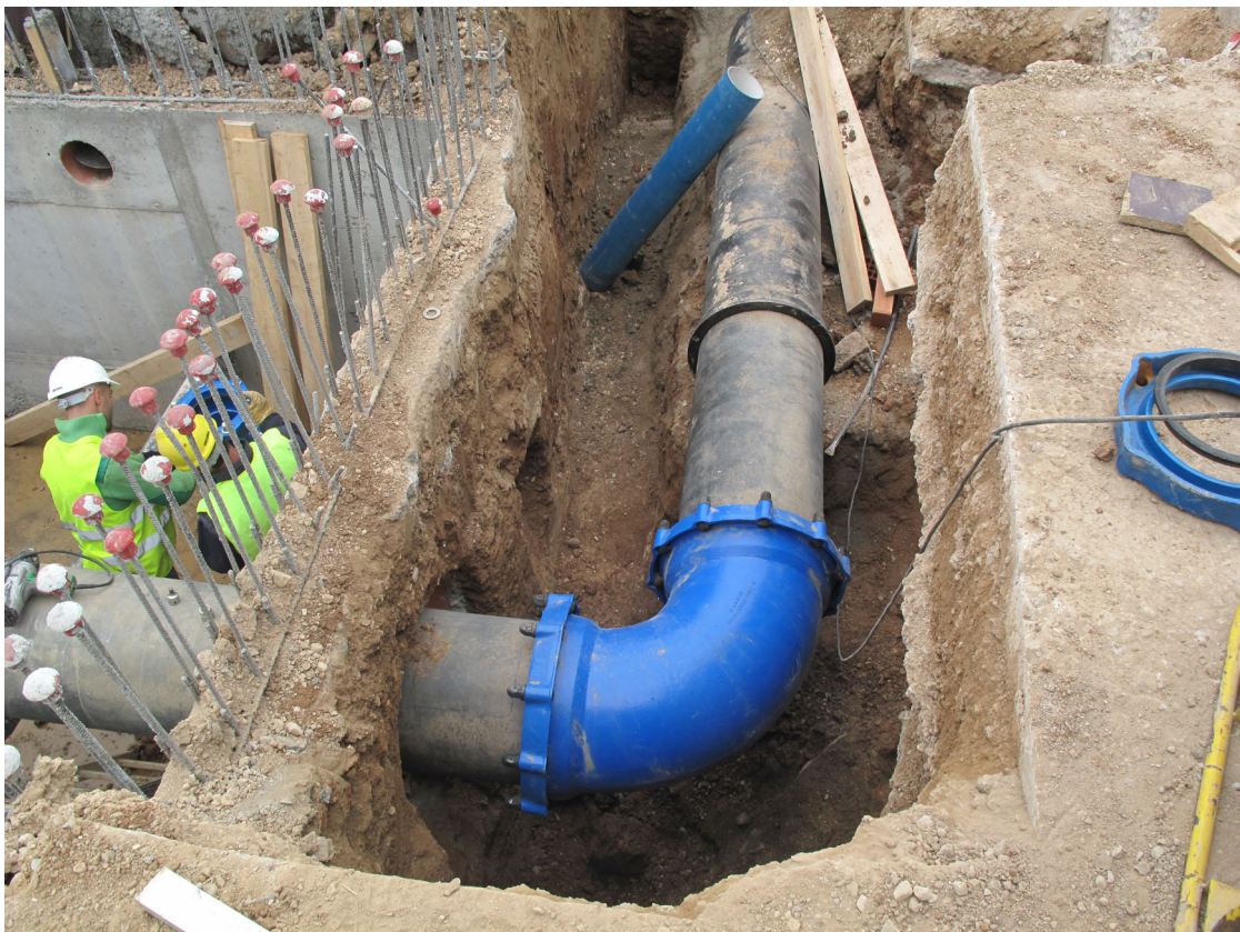
Figura núm.2 Punt de connexió Pk 0+000, colze a retirar per col·locació de TE
