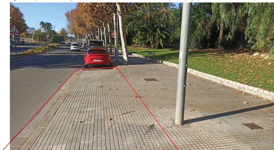
Figura 2. Implementació de paviment asfàltic en trams de retall de vorera (retranquejos)
