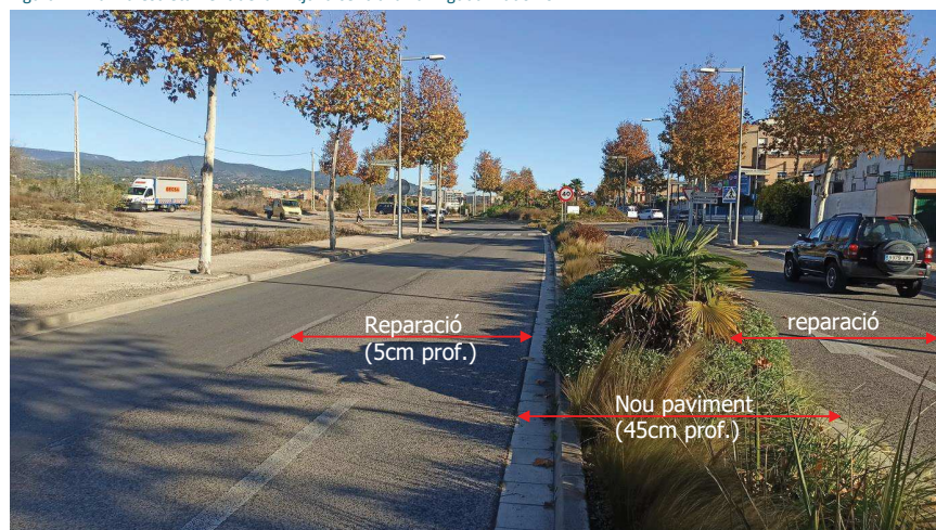
Figura 1. Tram d'estretament de la mitjana central a l'avinguda Riudoms
