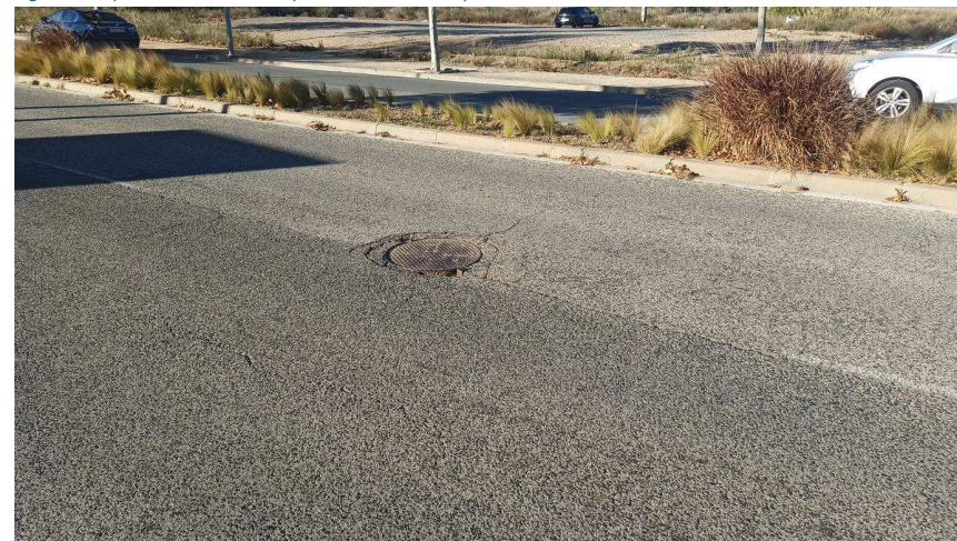
Figura 9. Arqueta existent afectada per la rehabilitació de paviment
