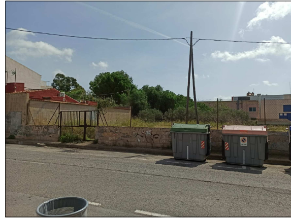
VISTA TANCA AMB CONSTRUCCIÓ
