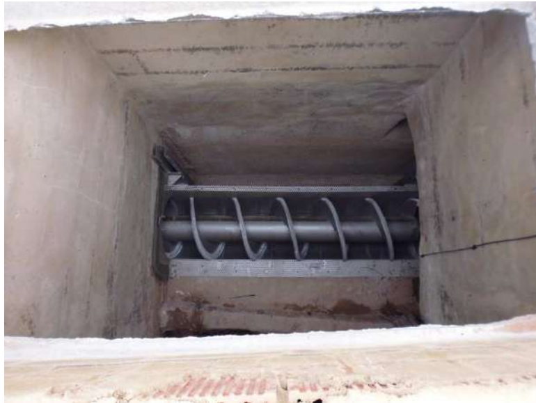
Tamiz embocado a una arqueta independiente
