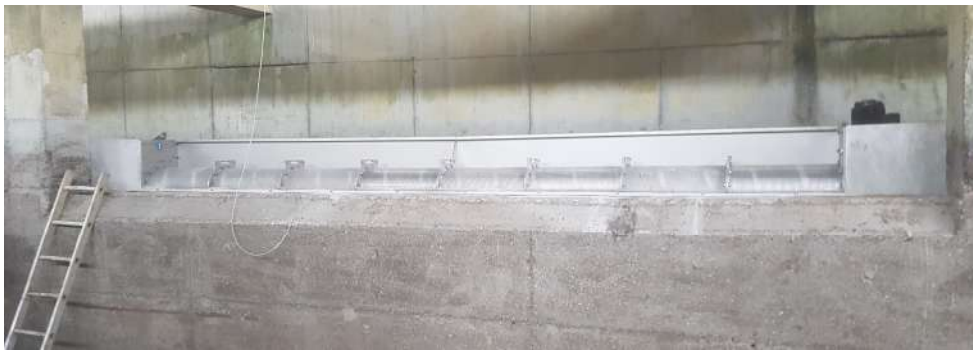
Figura 7: Imatge del tamís de neteja automàtica
