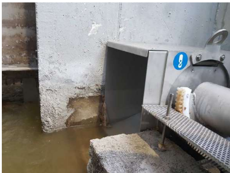
Detalle de la salida de un tamiz con retorno a cámara central.
