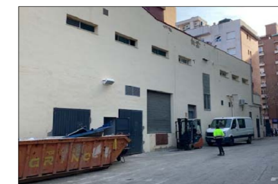
[F.2] VISTA ZONA CÀRREGA-DESCÀRREGA
