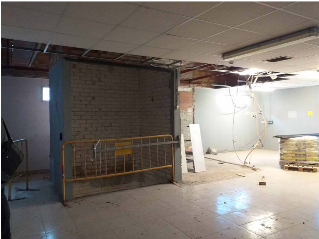
Vista general del magatzem de planta primera amb un dels muntacàrregues a enderrocar
