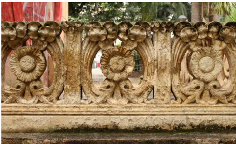
Vista parcial de la barana de la terrassa (foto: P.A.C.).
