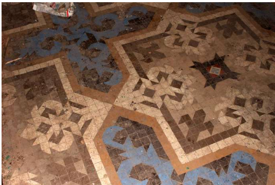
Detall del paviment de mosaic Nolla de la sala principal del mas (foto: P.A.C.).
