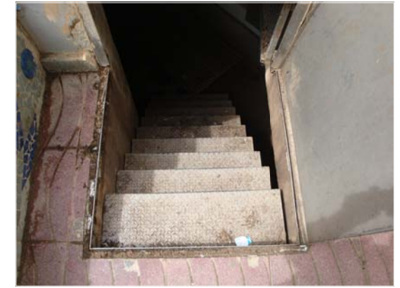
FOTO ESCALES D'ACCÉS EXISTENT A LA SALA DE CONTROL
