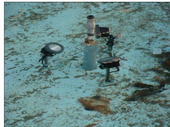
FOTOGRAFIES DELS FOCUS EXISTENTS OBSOLETS A SUBSTITUIR EN LA FONT ORNAMENTAL DE LA PLAÇA SANT JORDI
