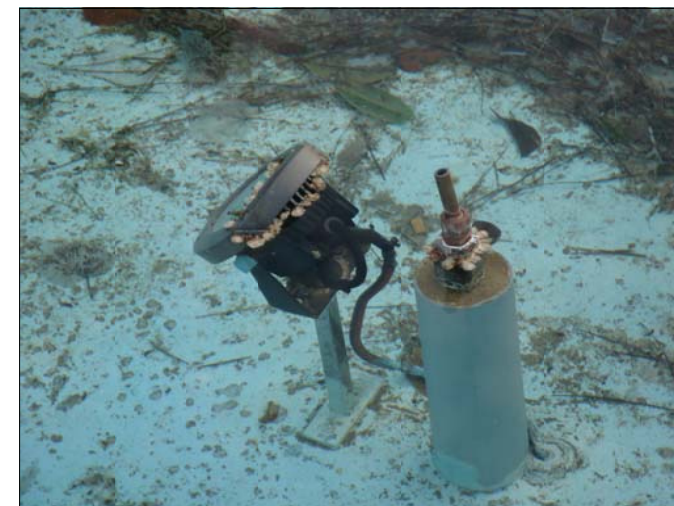
FOTOGRAFIES DELS FOCUS EXISTENTS OBSOLETS A SUBSTITUIR EN LA FONT ORNAMENTAL DE LA PLAÇA SANT JORDI
