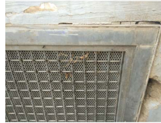
FOTO DETALL XAPA INOXIDABLE FORADADA EXISTENT
