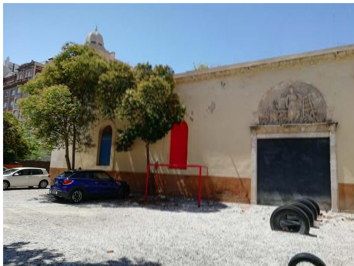
Façana interior escola
