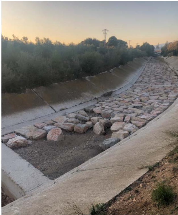
Figura núm.3 Estat dels elements de pedra col·locats en la llera de la Immaculada
