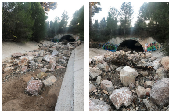
Figura núm.3 Arrossegament de l'escullera actual a l'entrada de l'obra de pas sota la T-11
