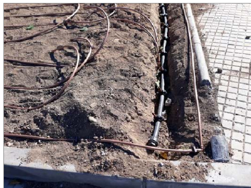
UNIÓ I CONNEXIÓ DELS TUBS DE GOTEIG INTEGRAT, DISTRIBUCIÓ A 25cm
