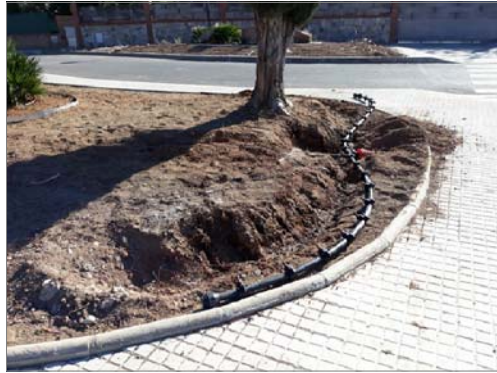
DETALLS DE COLLARINS Ø40 I ACCESORIS UNIÓ PER TUB GOTEIG DE Ø17, DISTANCIA ENTRE ELLS DE 25 cm
