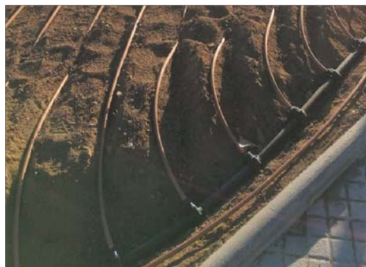
UNIÓ I CONNEXIÓ DELS TUBS DE GOTEIG INTEGRAT, DISTRIBUCIÓ A 25cm
