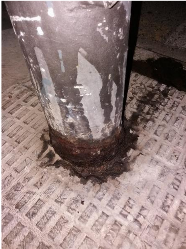
Suport afectats per la corrosió de la base
