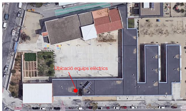
Figura 5 Situació equips elèctrics
