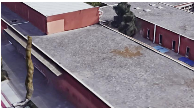
Figura 6 Zona equips elèctrics
