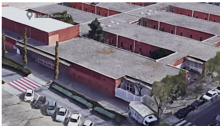
Figura 3 Vista general de coberta amb previsió de camp fotovoltaic
