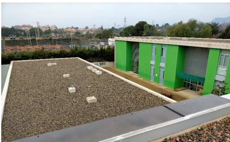
Figura 3 Vista general de coberta amb previsió de camp fotovoltaic
