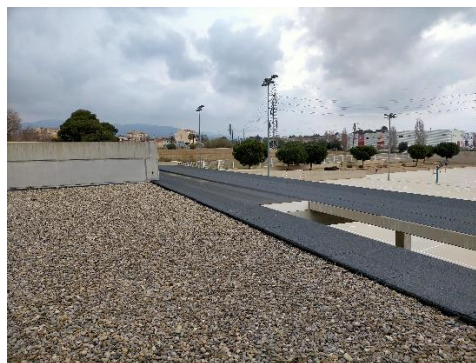
Figura 6 Zona equips elèctrics
